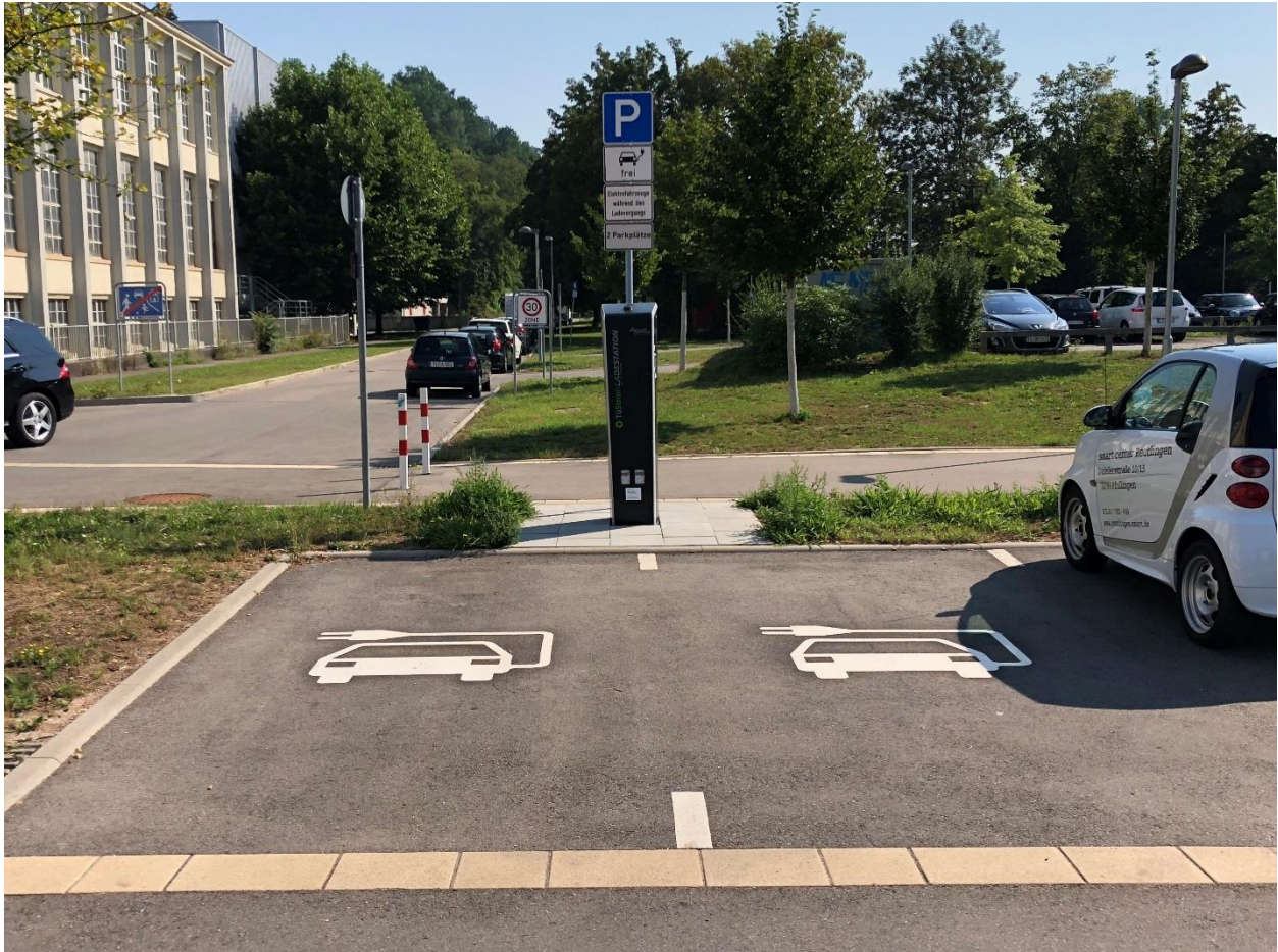
Abbildung 9 Ladesäule Egeria/Alte Weberei mit Markierung und Positiv-Beschilderung
