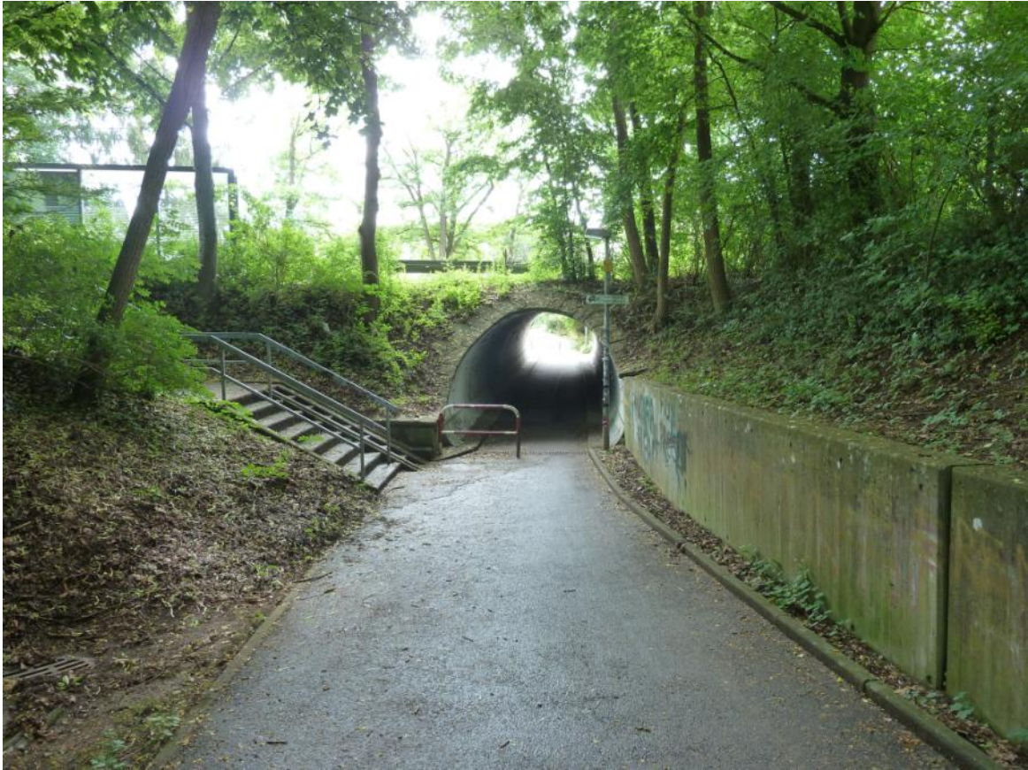
Abbildung 13 Rad/Fußgänger-Unterführung, die auch von Fledermäusen zur Querung der B 28 genutzt wird.
