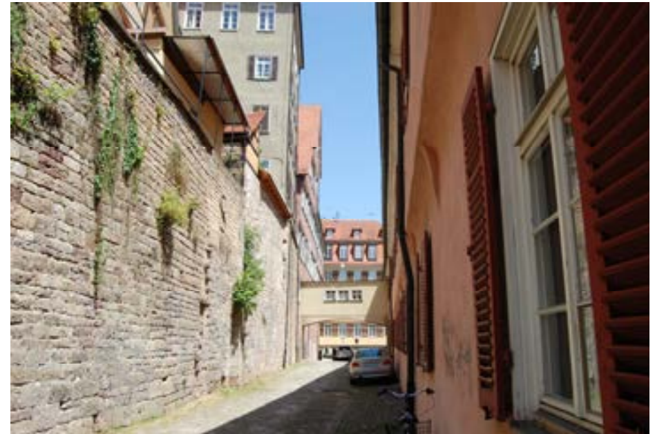
Clinicumsgasse Höhe ehem. Burse mit hoher Stützmauer zur Münzgasse hin.
