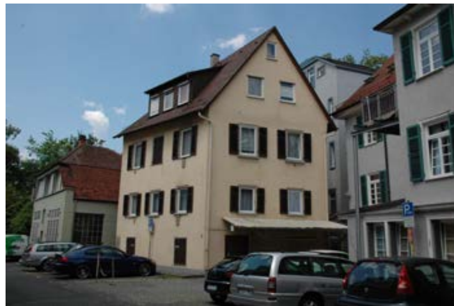
Ansicht gegen die Hintere Grabenstraße
