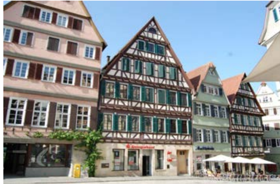
Die erhaltene Südfassade des Neubaus von 1978
