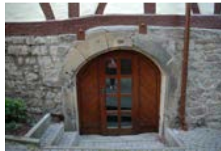
Detail segmentbogiges Kellerportal
