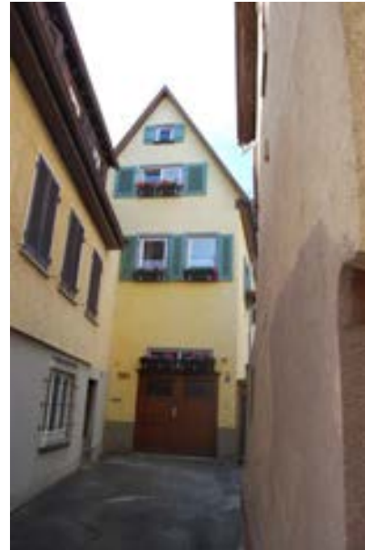
Nordfassade gegen die Bachgasse
