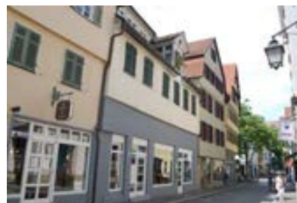
Nr. 11 mit ehem. Aufzugsgaube
