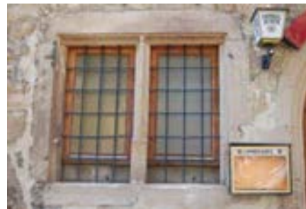
bauzeitliches Steingewändefenster
