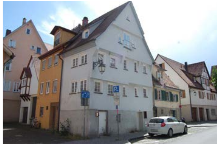
Eckansicht am Eingang der Urbangasse
