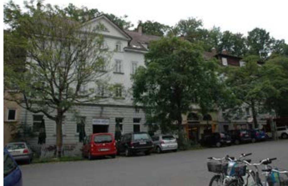
Blick auf die Nordfassade vom Platz "Vor dem Haagtor" aus
