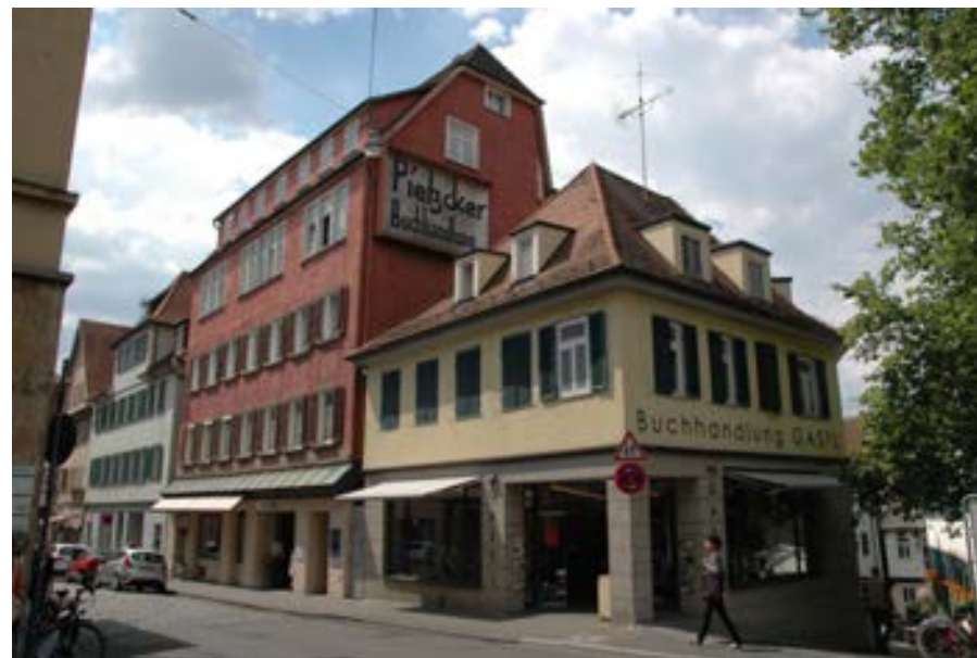
Blick in Richtung Neue Straße
