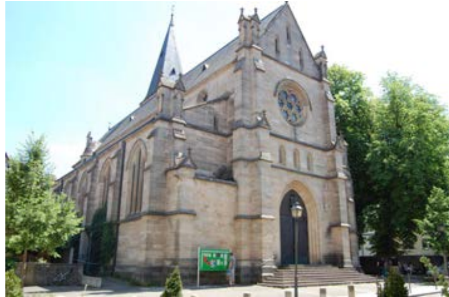
Blick auf die Westfassade
