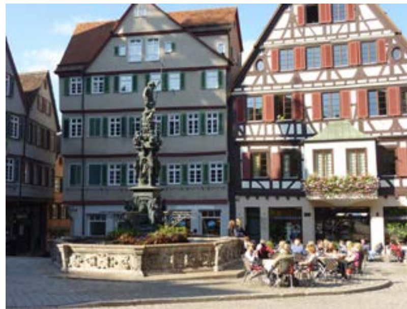
Brunnen mit den Gebäuden Am Markt 3 und 5 im Hintergrund (Aufn. 2016,
