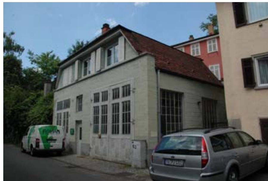
Ansicht gegen die Hintere Grabenstraße
