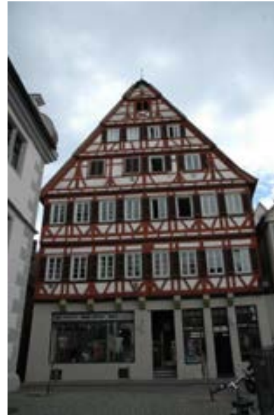
Blick auf die Nordfassade
