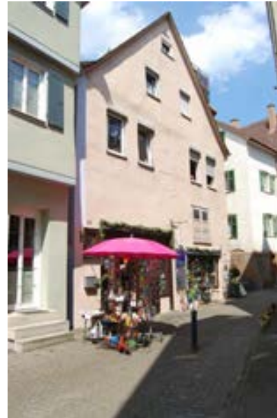
Südfassade zum nordöstlichen Stich der Langen Gasse
