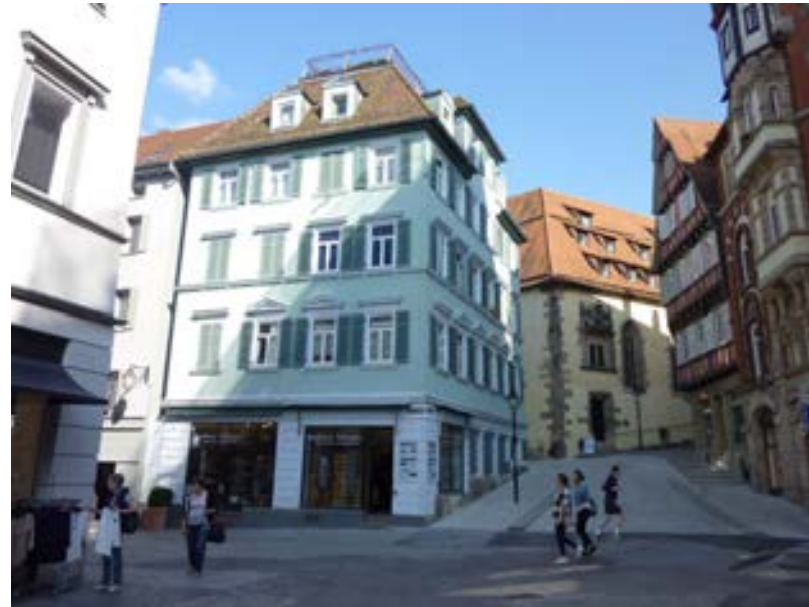
nach der Fassadenrenovierung (Aufn. 2016, Stadtplanungsamt)
