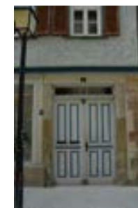
bauzeitliche Rahmenfüllungstüre
