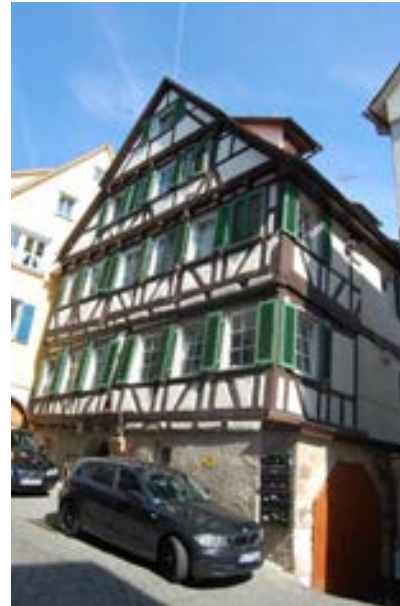
Blick auf die Südfassade und den seitlichen Kellerzugang
