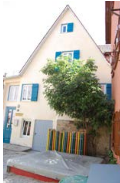
Blick auf die Westfassade
