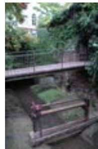
Brücke und Wehr Höhe Metzgergasse
