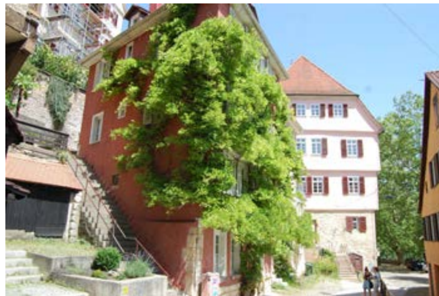
Ansicht mit ehem. Burse (rechts im Hintergrund)
