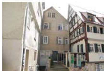
Bursagasse 18/4 (ehem. Scheune)
