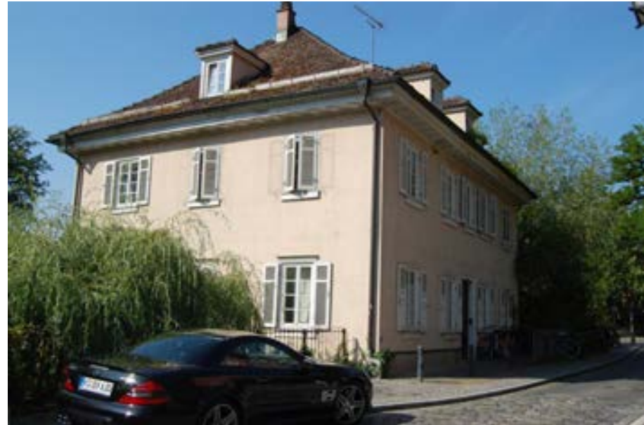
Blick auf die Straßenfassade (von Nordosten)
