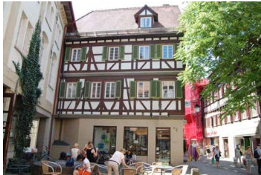
Blick auf die Ostfassade
