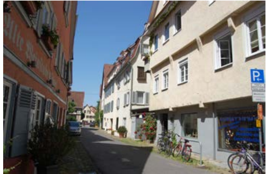
Östlicher Gasseneingang Höhe Schmiedtorstraße
