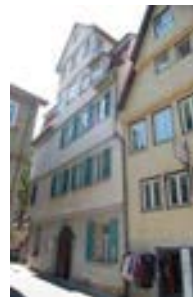
Fassade zur Froschgasse
