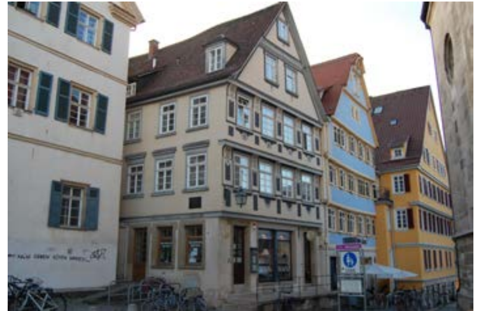
Das sog. Cottahaus gegenüber der Stiftskirche mit repräsentativer Fassadengestaltung des 18. Jahrhunderts.
