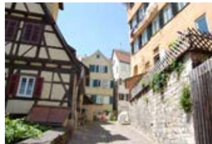
Rückgebäude mit Stützmauer
