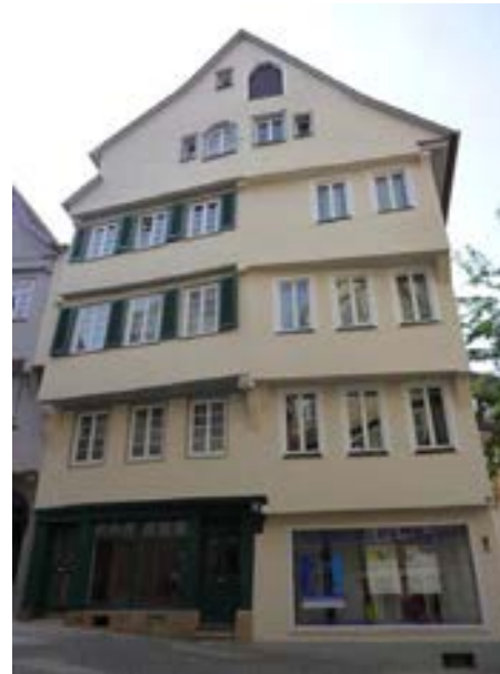
Münzgasse 4 (links) und 2 nach der Sanierung (Aufn. 2016, Stadt)
