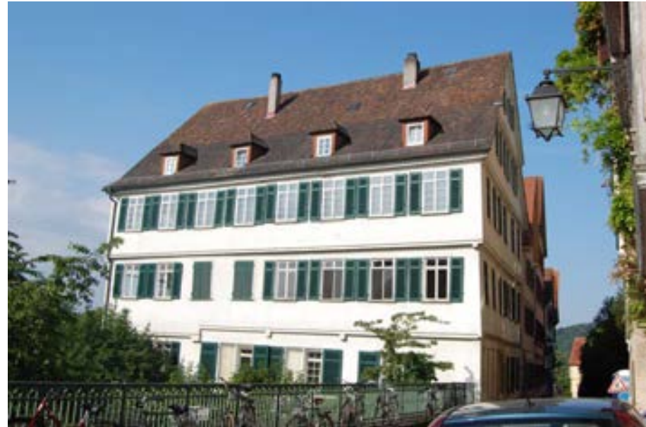
Blick auf die Ostfassade
