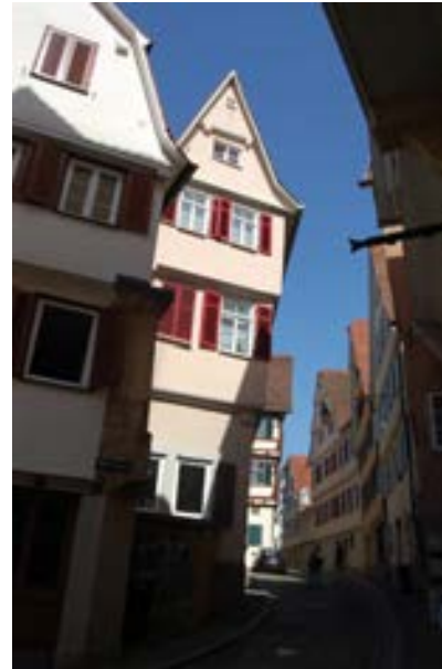
westliche Giebelseite gegen das "Faule Eck"
