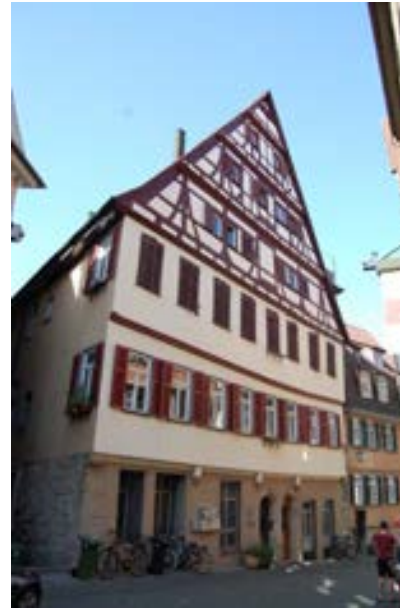
Südfassade an der Kronenstraße
