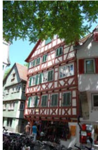
Westfassade zur Hirschgasse
