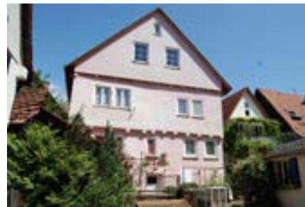
Blick auf die Rückfassade
