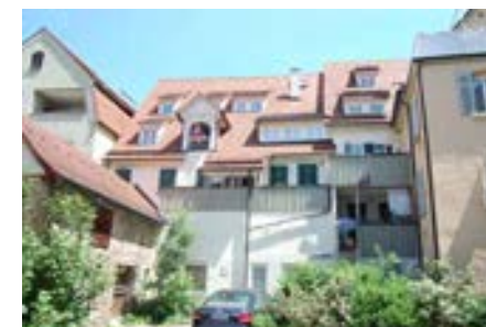
Blick auf die Rückfassaden
