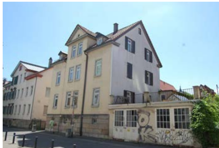
Ansicht von Nordwesten mit jüngerm Garagenanbau
