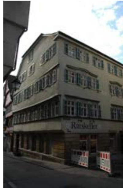
Eckansicht des südlichen Gebäudeteils von 1415 (d)
