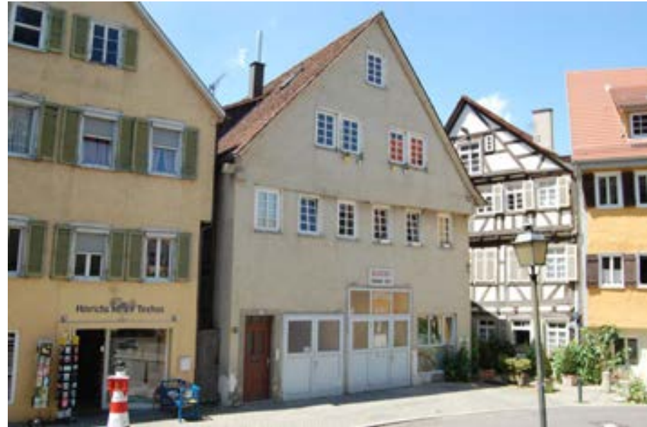
Ansicht gegen die Froschgasse
