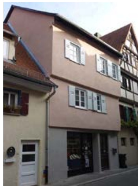
Bachgasse 13 nach der Sanierung (Aufn. 2016, Stadtplanungsamt)
