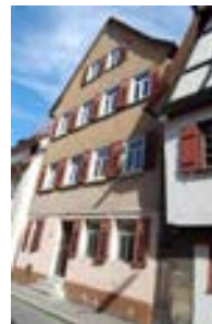
vor der Sanierung (Aufn. 2014)
