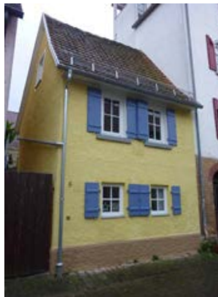
nach der Sanierung (Aufn. 2016 Stadtplanungsamt)
