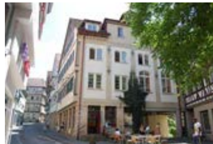
Das erhaltenswerte Gebäude
