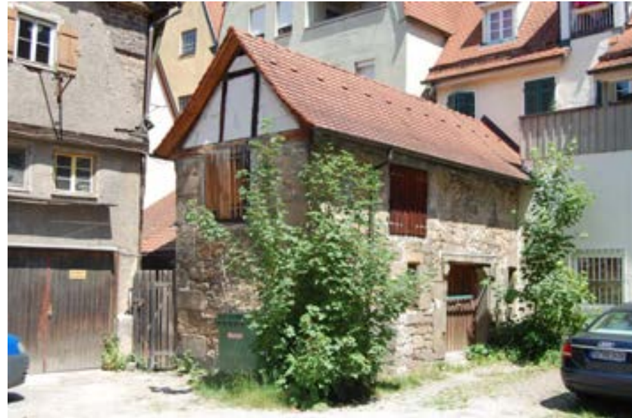
Das ehem. Brauhaus im Hof hinter Froschgasse 12
