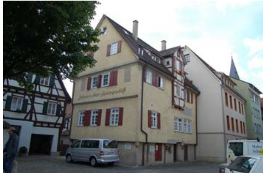
Eckansicht gegen Nordosten, links das liegt das ehem. Nonnenhaus
