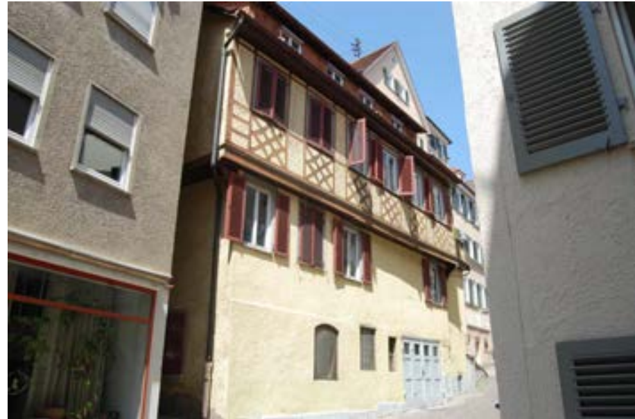
Südfassade mit Zierfachwerk der Zeit um 1900
