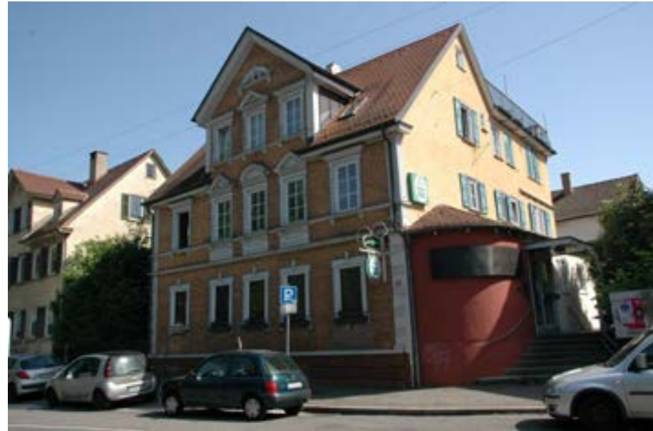
Hauptfassade gegen die Straße Am Stadtgraben
