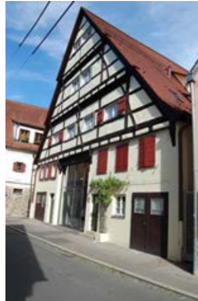
Ansicht von Südosten
