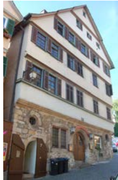
Blick auf die Nordfassade mit Kellerzugang
