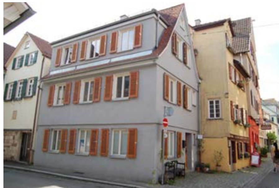
Eckansicht zur Bachgasse
