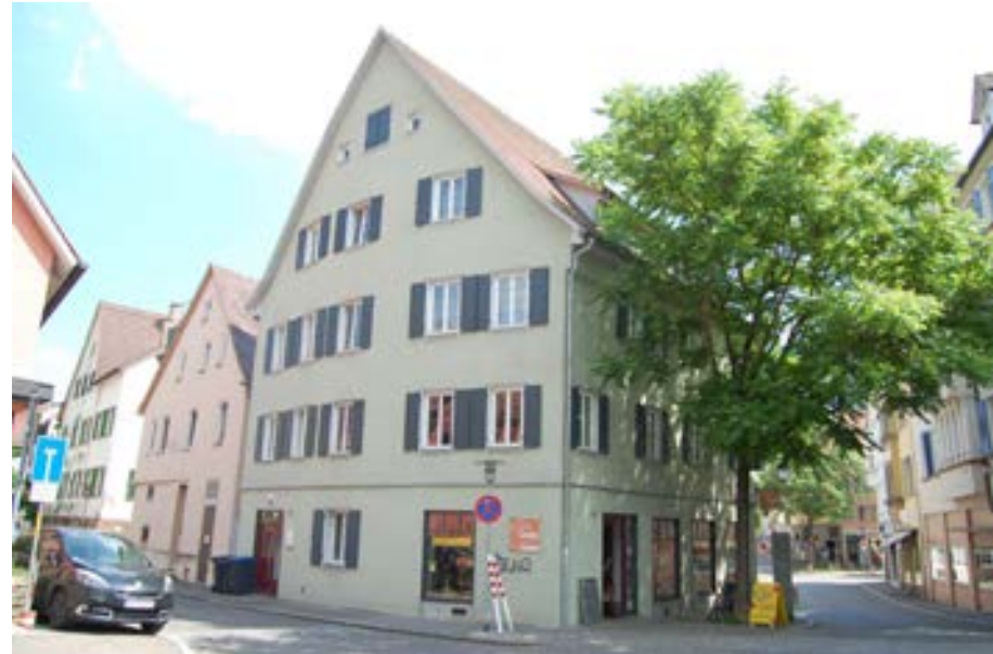
Nordansicht gegen die Hintere Grabenstraße
