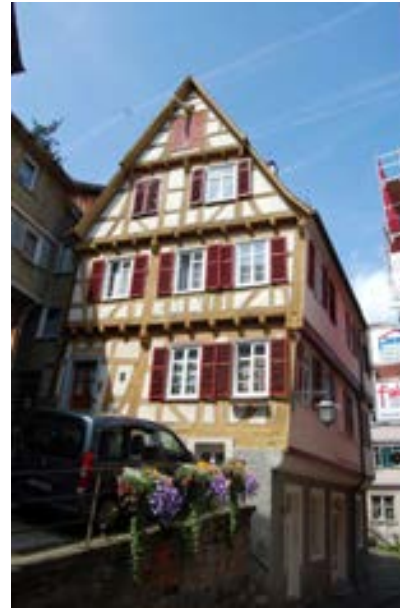
Blick auf die Ostfassade
