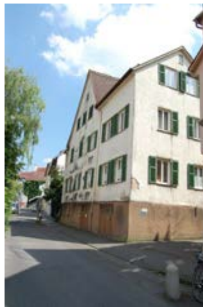
Ansicht gegen die Hintere Grabenstraße
