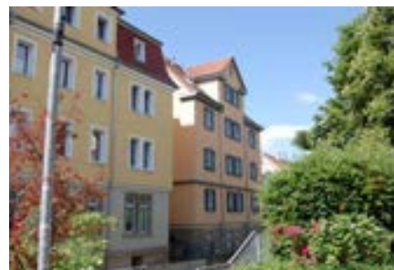
Nordfassade gegen die Ammer
