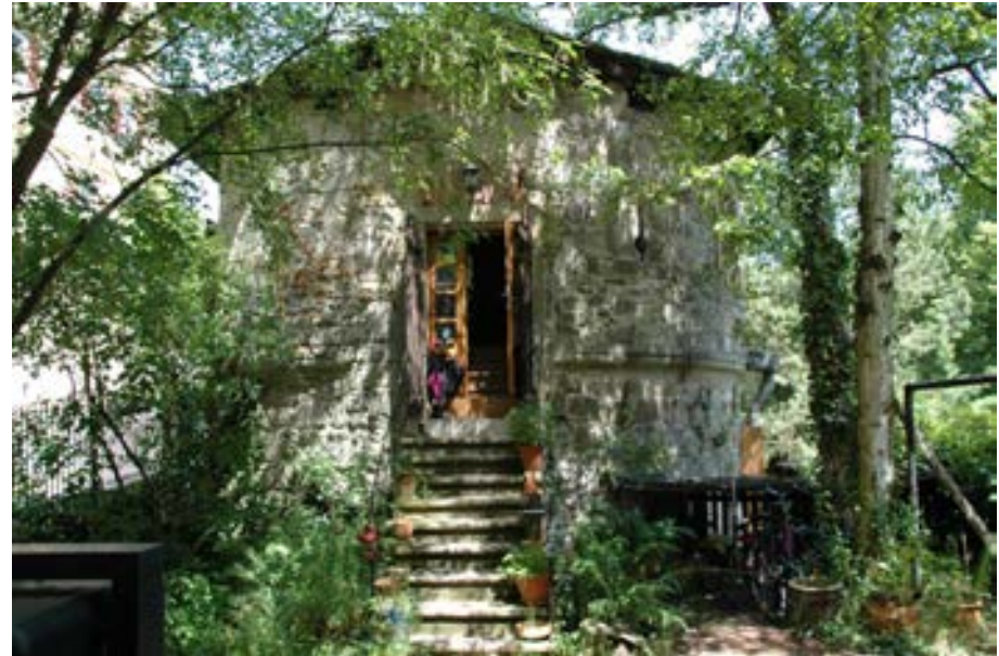
Ansicht gegen Westen mit Schlüsselscharte und Gurtgesims
