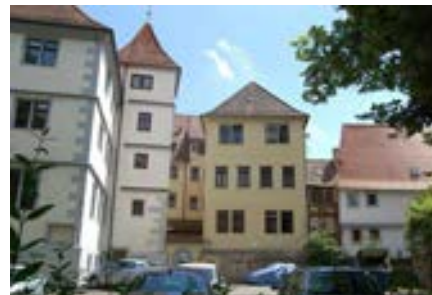
Blick auf die Nordfassade
