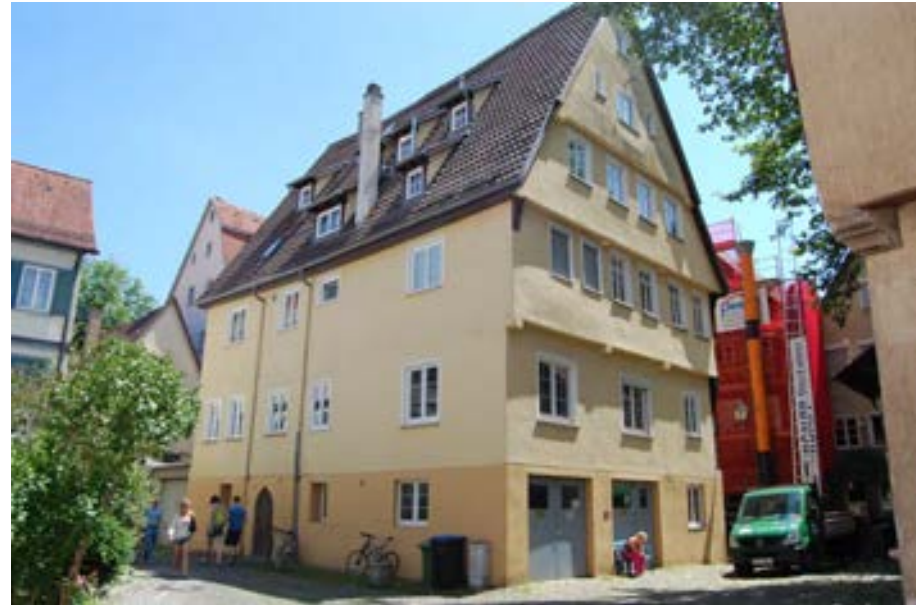
Eckansicht von Nordwesten gegen die Aufweitung der Neustadtgasse
