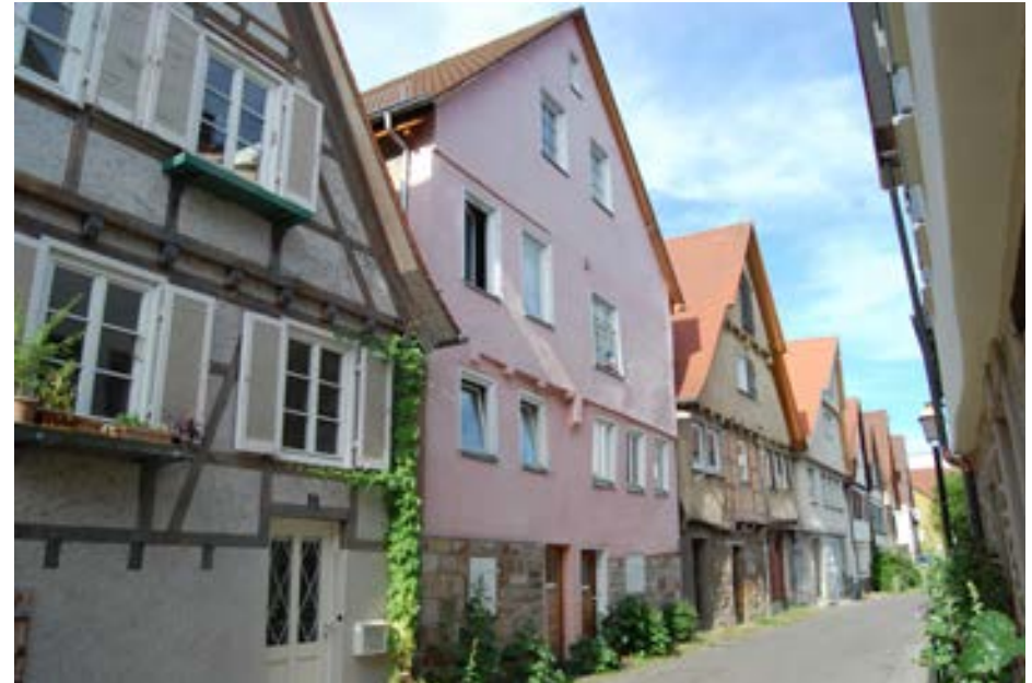
Blick in die Gasse „Am kleinen Ämmerle“ mit kleinteiligen, ehemals von Weinbauern und Kleinhandwerker bewohnten Gebäuden. Die massiven Erdgeschosse beherbergten einst Lager- oder Werkstattträume sowie Ställe.
