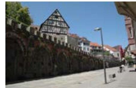
Stützmauer entlang der Mühlstraße
