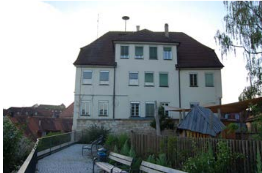
Blick auf die Ostfassade
