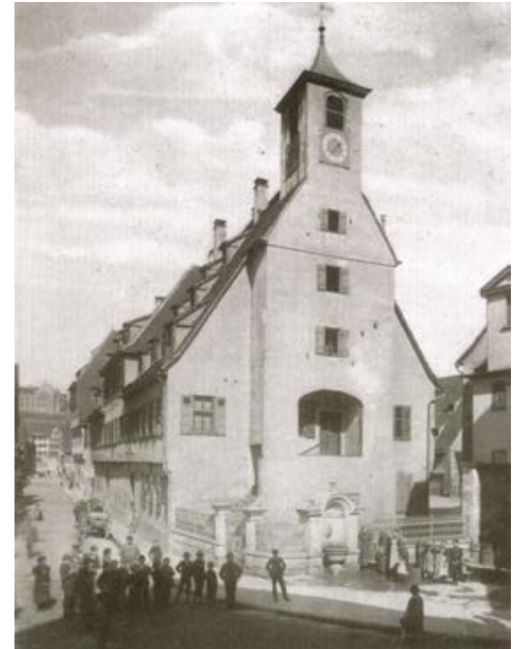
Das Spital in der Schmiedtorstraße im Jahr 1899 kurz vor seinem Umbau (aus: Rauch, Tübinger Stadtbild).
