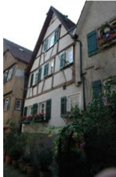
Ansicht von Südosten
