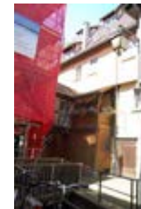
Außentreppe und "Sprachhaus"
