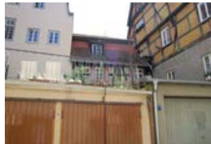
Blick auf die Nordfassade
