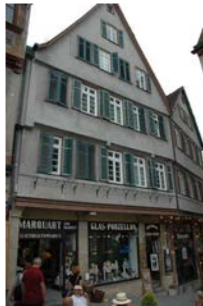
Die beiden zum Marktplatz hin ausgerichteten Vorgerhäuser alte HsNr. 835
