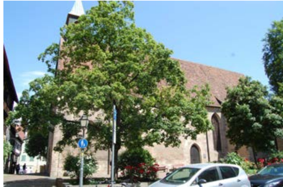
Blick auf die Südfassade zur Jakobsgasse
