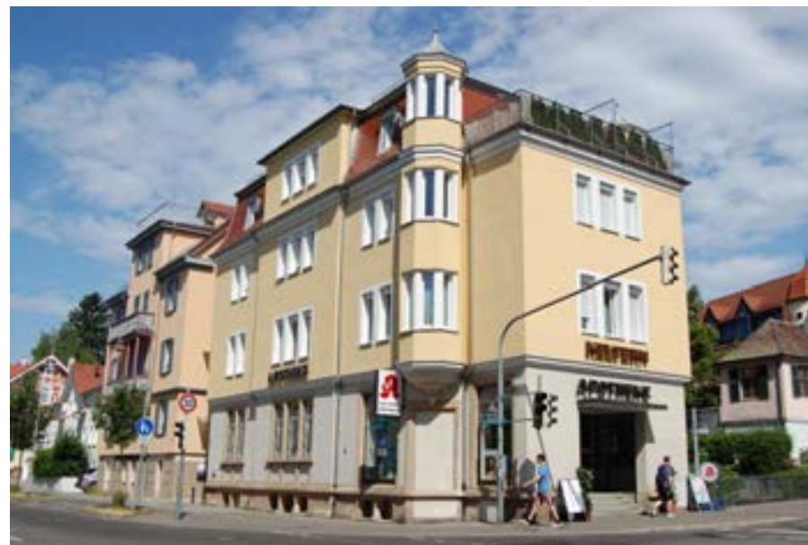
Markante Kopflage am nördlichen Stadteingang
