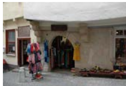
Erdgeschoss mit Steinkonsolen
