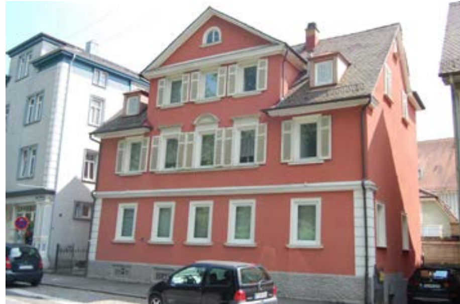
Hauptfassade gegen die Straße Am Stadtgraben
