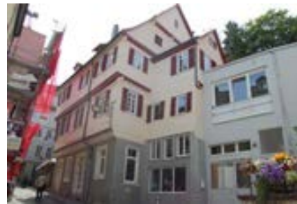
Ansicht von Südwesten mit Anbau
