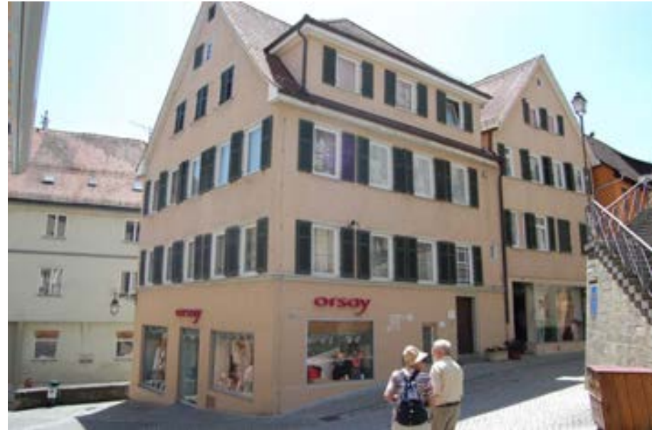
Ansicht gegen die Neckargasse von Nordosten
