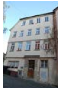
Nordfassade gegen den Schulberg
