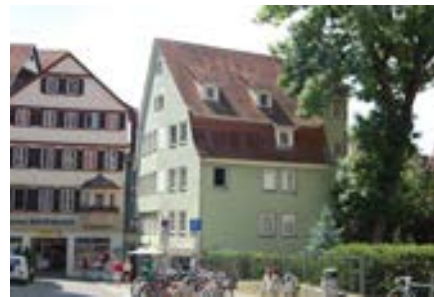
Blick auf die Ostfassade
