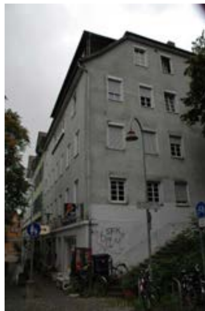
Blick auf die Westfassade
