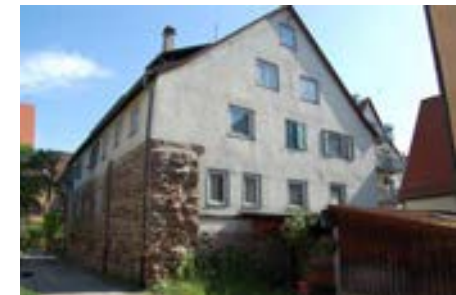
Ansicht gegen Südwesten
