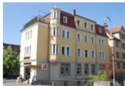
Nordfassade gegen die Ammer
