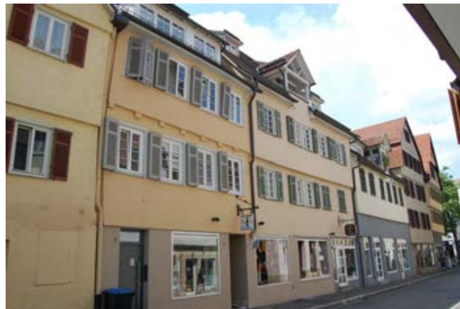
Gesamtansicht Lange Gasse 7 bis 11
