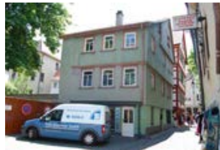
Blick auf die Nordfassade
