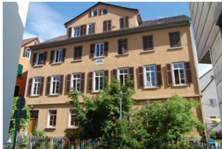
Ansicht gegen Süden, gegen den alten Zwingerbereich
