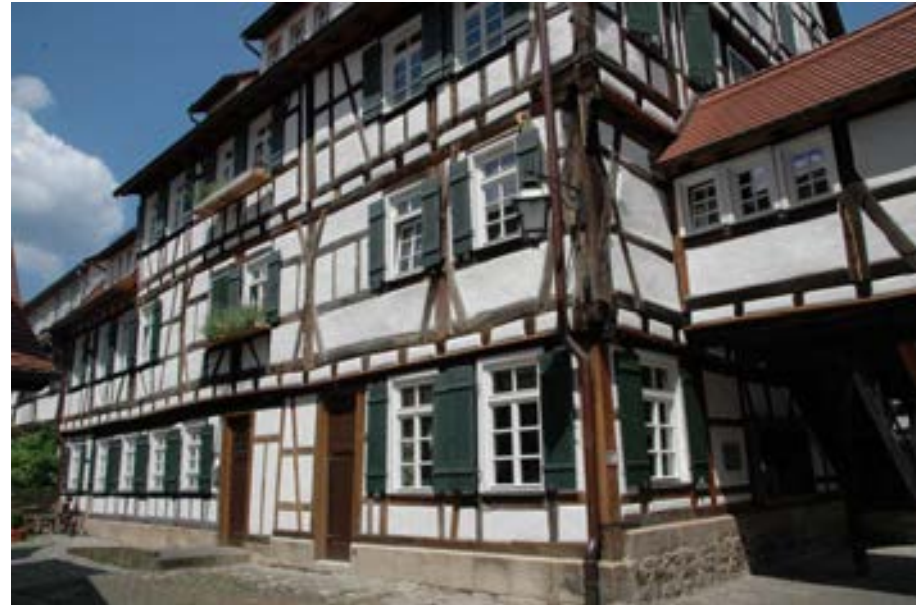
Nr. 7: Blick auf die Westfassade mit anschließendem ehem. Aborterker.
