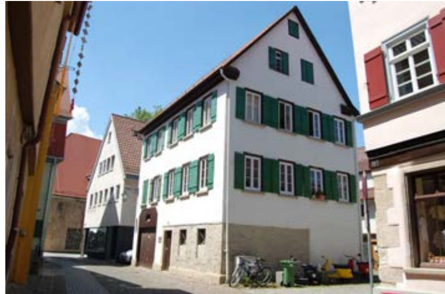
Ansicht gegen Südosten
