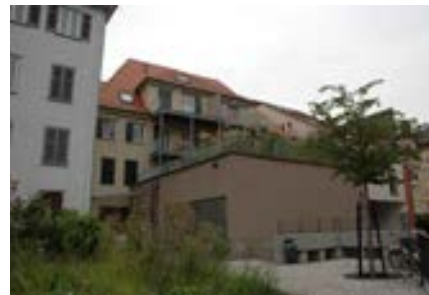
Rückfassade mit Flachdachanbau
