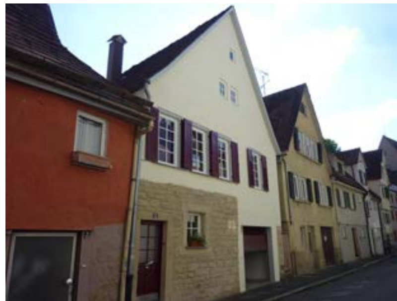
Bachgasse 12 nach der Sanierung (Aufn. 2016, Stadtplanungsamt)
