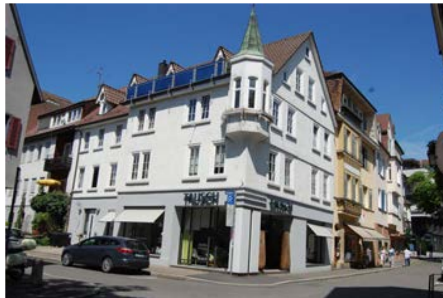
Eckansicht von Südosten
