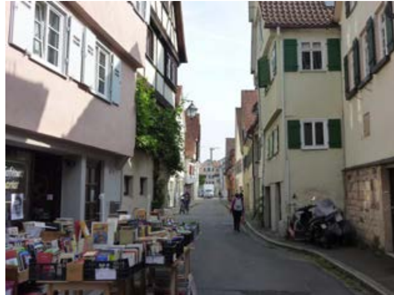
Blick nach Osten mit typ. handwerklich-kleinbäuerlicher Gebäudestruktur
