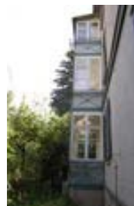
Standerker an der Rückfassade
