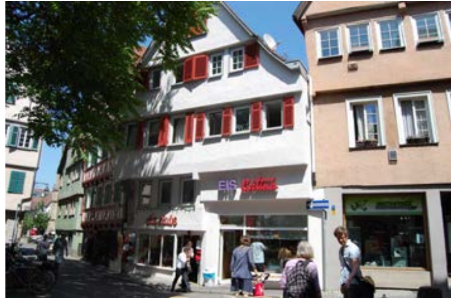
Blick auf die Westfassade an der Hirschgasse
