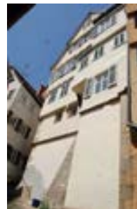
Stützmauer an der Clinicumsgasse
