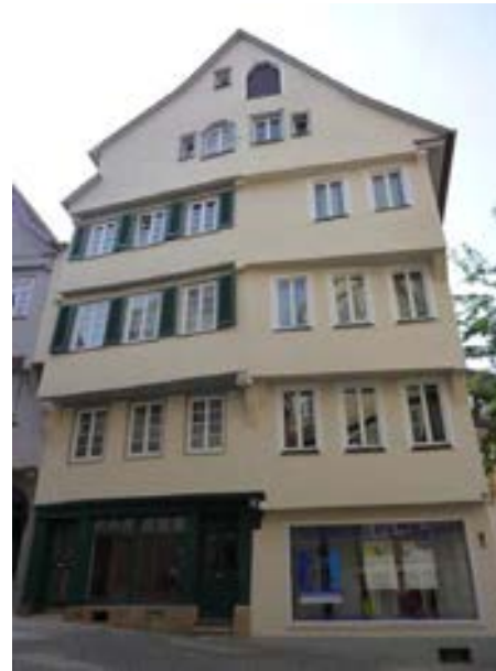
Münzgasse 2 (rechts) und 4 nach der Sanierung (Aufn. 2016, Stadt)
