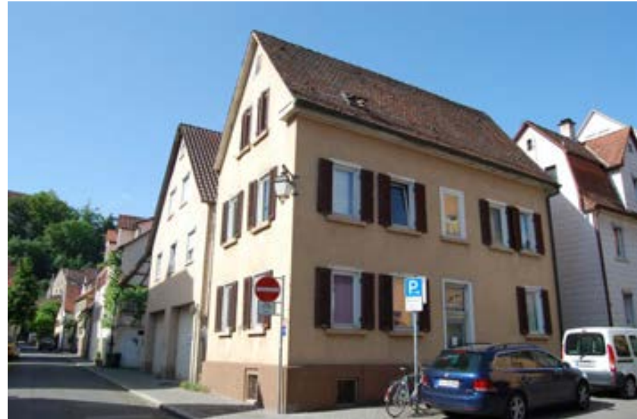
Eckansicht gegen die Seelhausgasse
