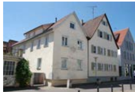
Ansicht der Rückfassade
