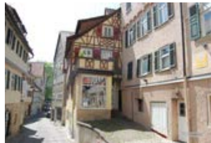
Blick auf die schmale Ostfassade
