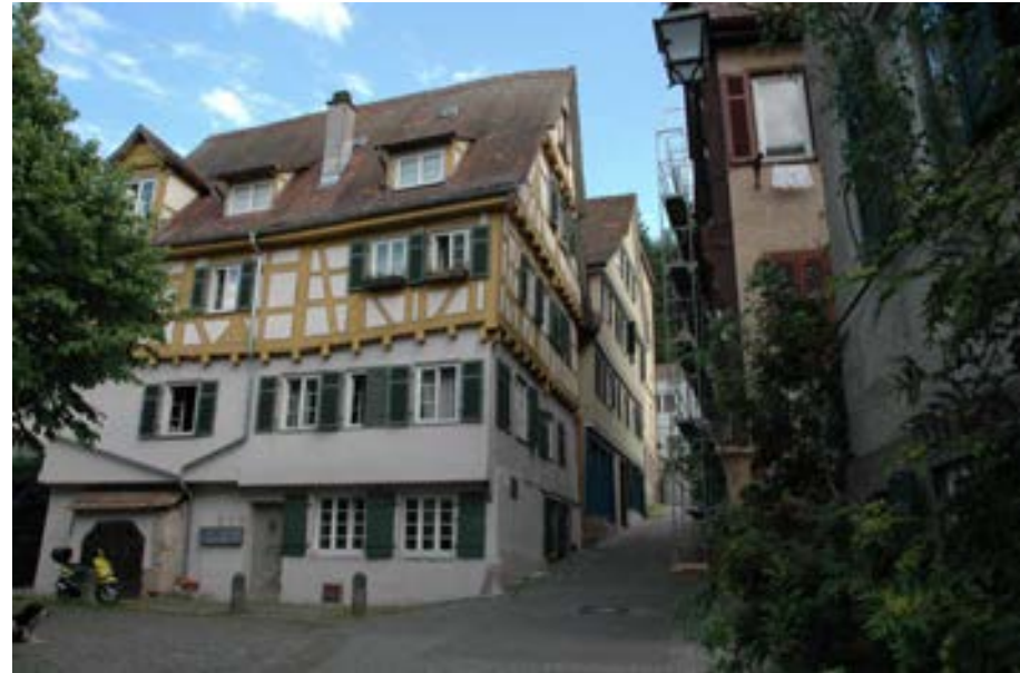
Blick auf die Nordfassade mit seitlichem Kellerabgang
