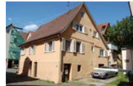
Hoffassade von 6 und 6/2 (2014)
