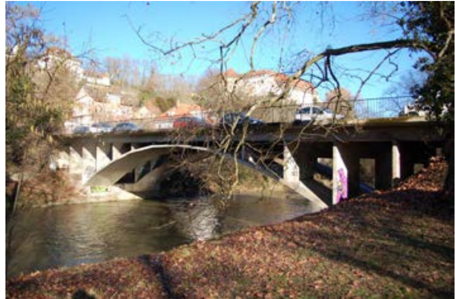
Nördlicher Teil der Brücke über dem Neckar
