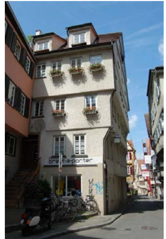
Aufgrund der räumlichen Enge wachsen die Gebäude der Haaggasse vielfach „über sich hinaus“.
