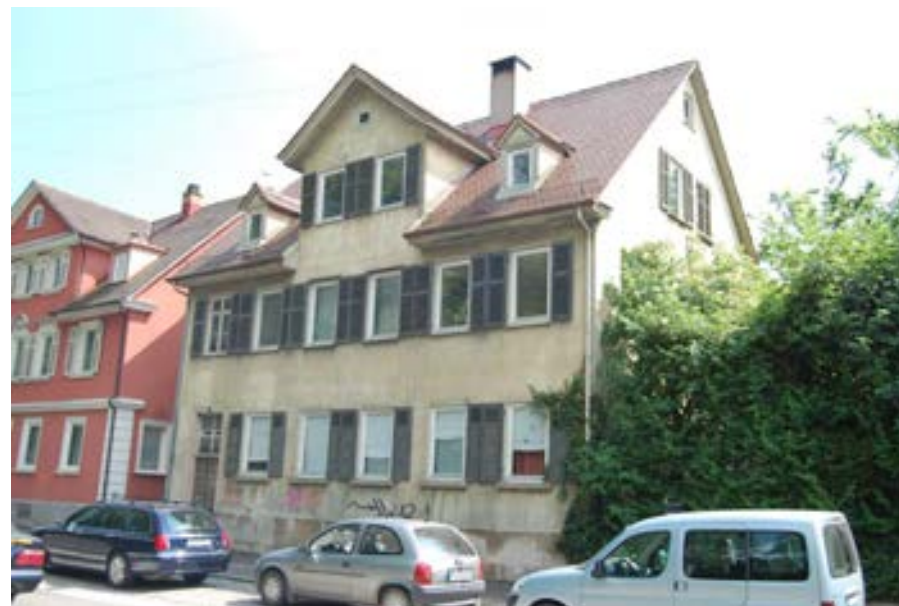
Hauptfassade gegen die Straße Am Stadtgraben
