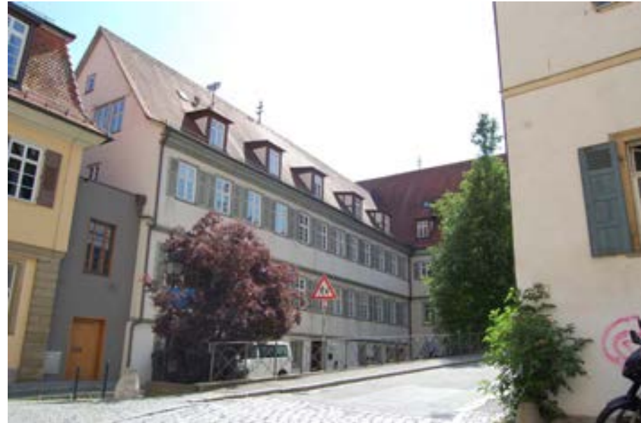
Nr. 24 mit Flügelbau Nr. 26 und 28
