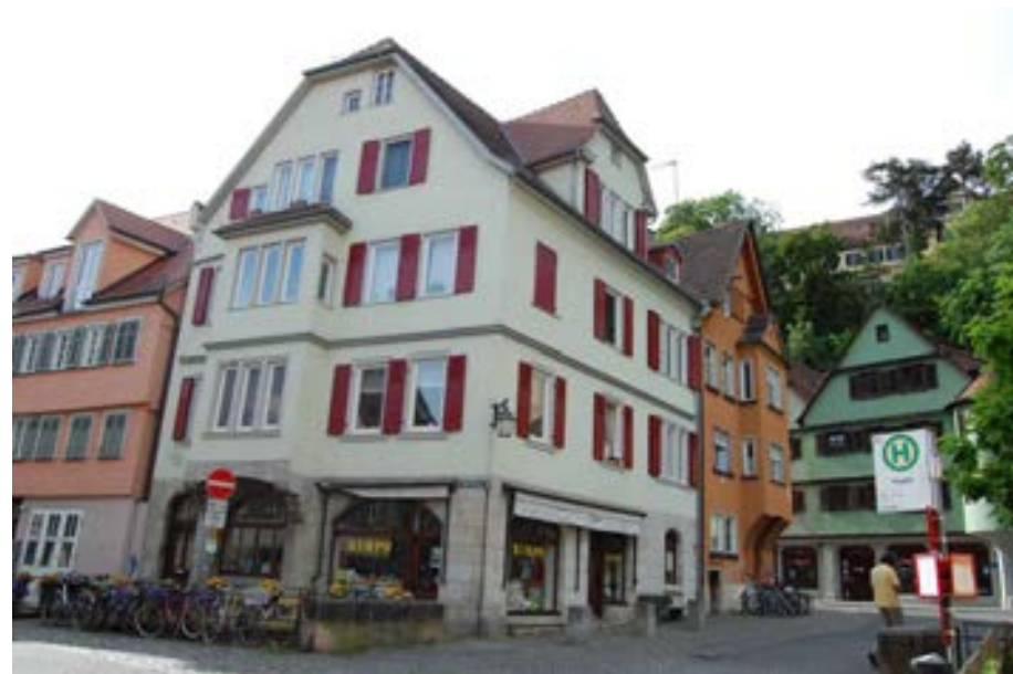
Eckansicht gegen die Seelhausgasse
