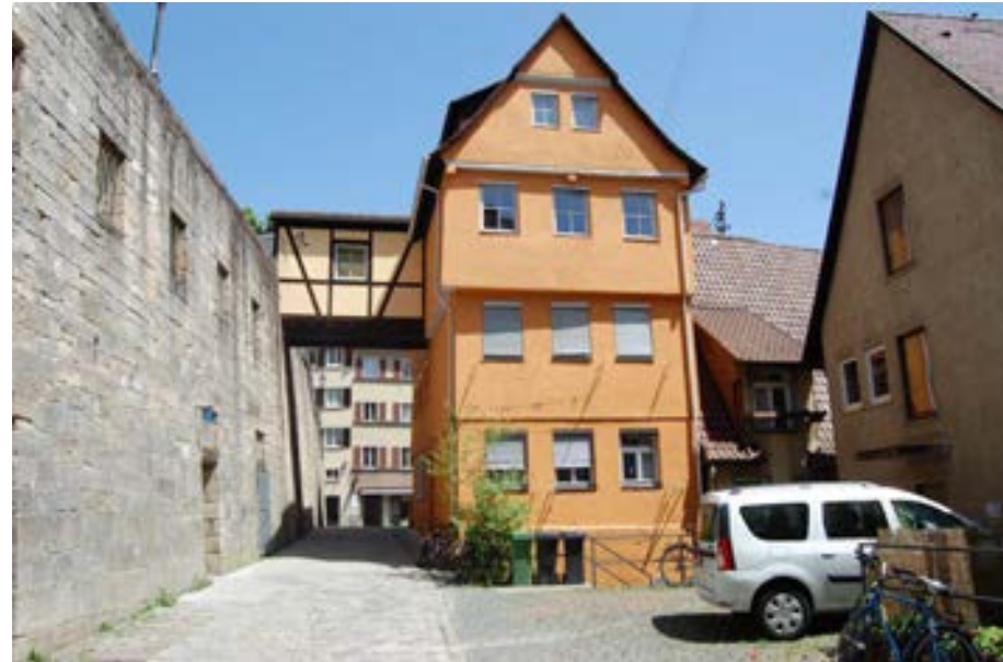
Westfassade mit Übergang zum Platz an der Stiftskirche
