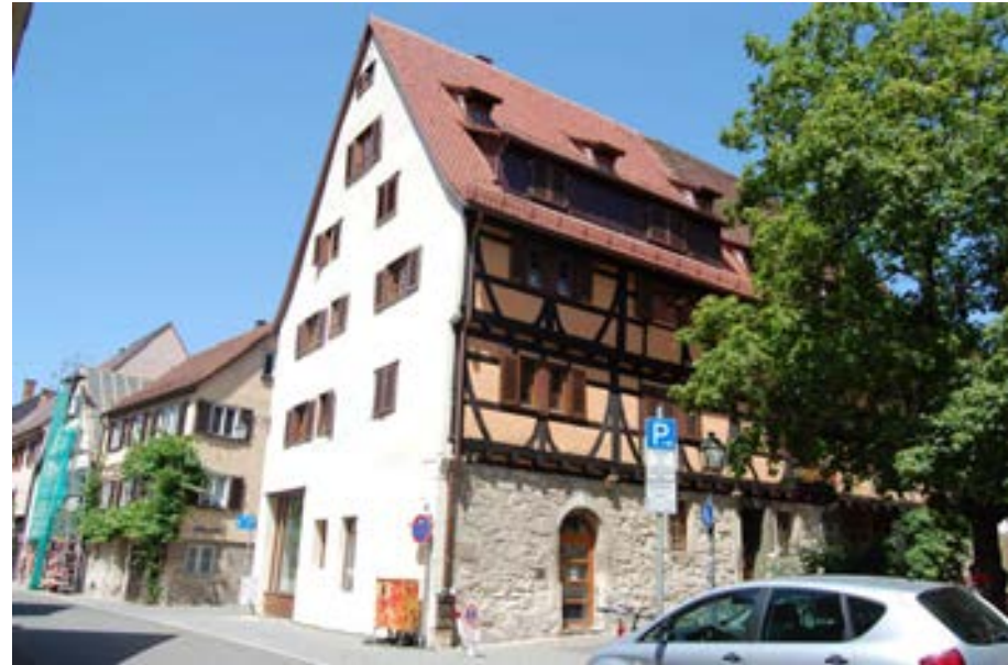
Eckansicht von Südosten
