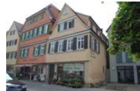
Ansicht mit Schmiedtorstraße 6 (re)
