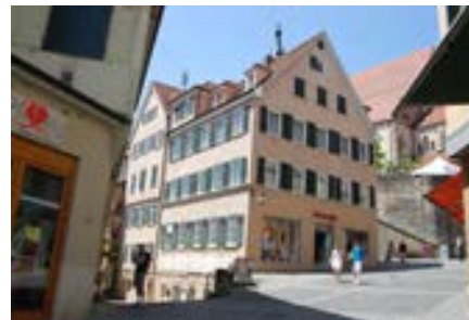
Eckansicht von Südosten
