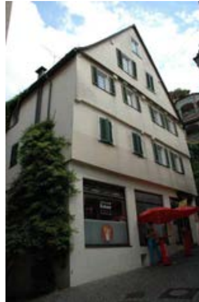
Westfassade an der Stichgasse zur Metzgergasse
