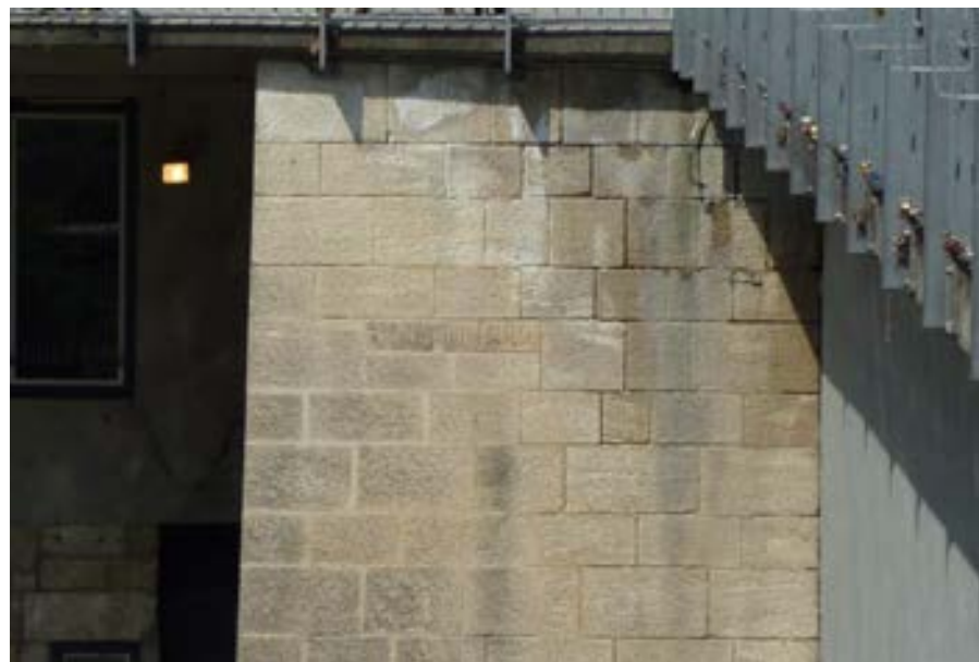
Brückenpfeiler mit rechteckigem Fragmentstein
