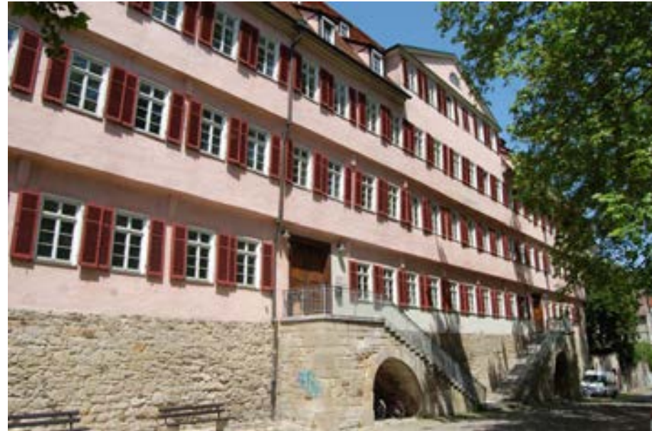
Blick von Südwesten auf die Hauptfassade der ehem. Burse
