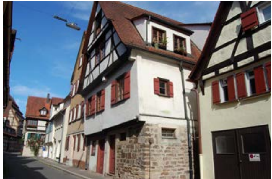
Ansicht von Südosten. Im EG zeichnet sich der ehem. Stall deutlich ab.
