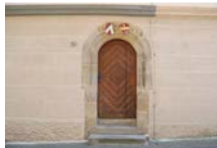
Detail: Portal im Verbindungsbau
