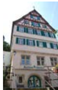
Nordfassade mit Rundbogenportal
