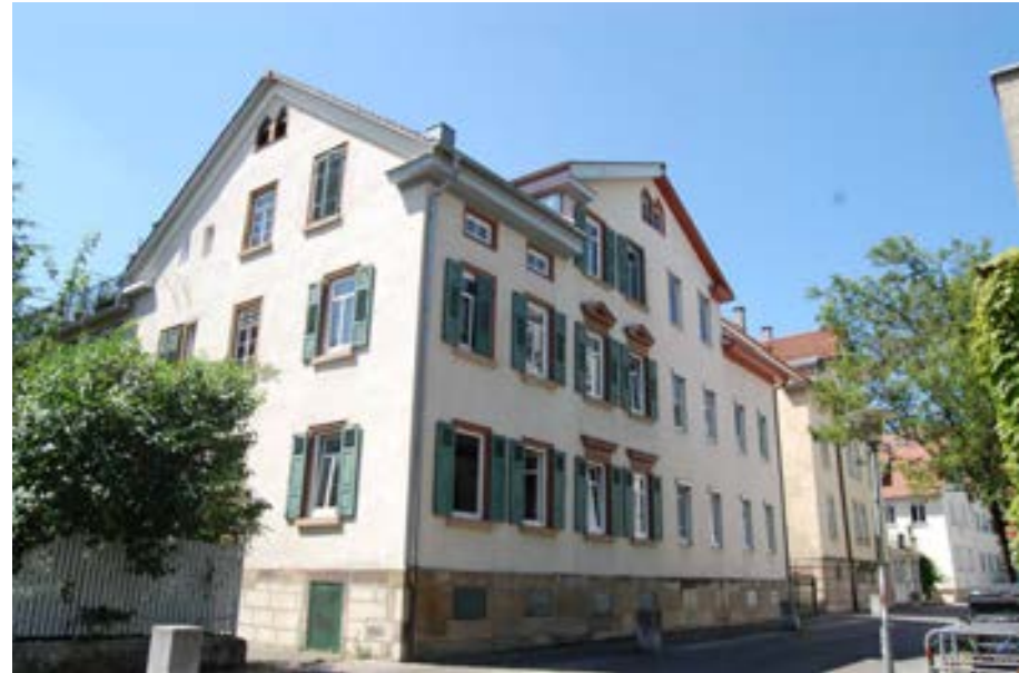
Ansicht von Nordosten, im Vordergrund Nr. 25
