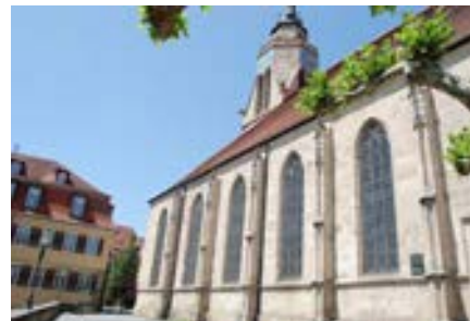
Südfassade mit Alter Aula (li)
