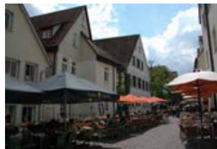
Nordfassade mit Anbau
