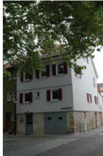
Eckansicht gegen die Seelhausgasse
