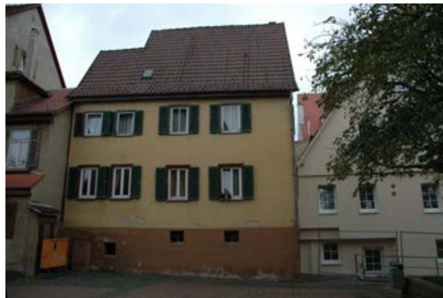
Blick auf die Westfassade
