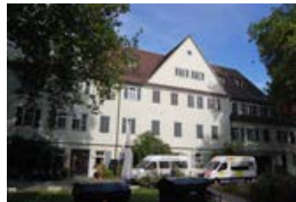
Hofansicht des Westtraktes
