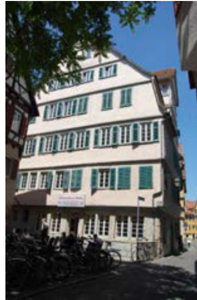
Blick von der Hirschgasse auf die Südfassade
