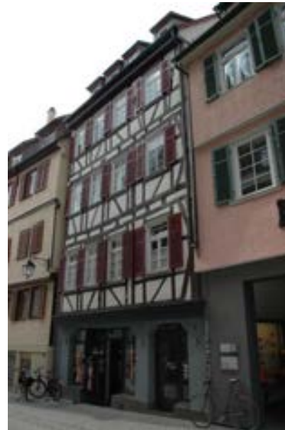
Ansicht von Südosten
