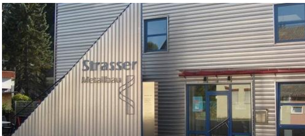
Bild: Strasser Metallbau GmbH
