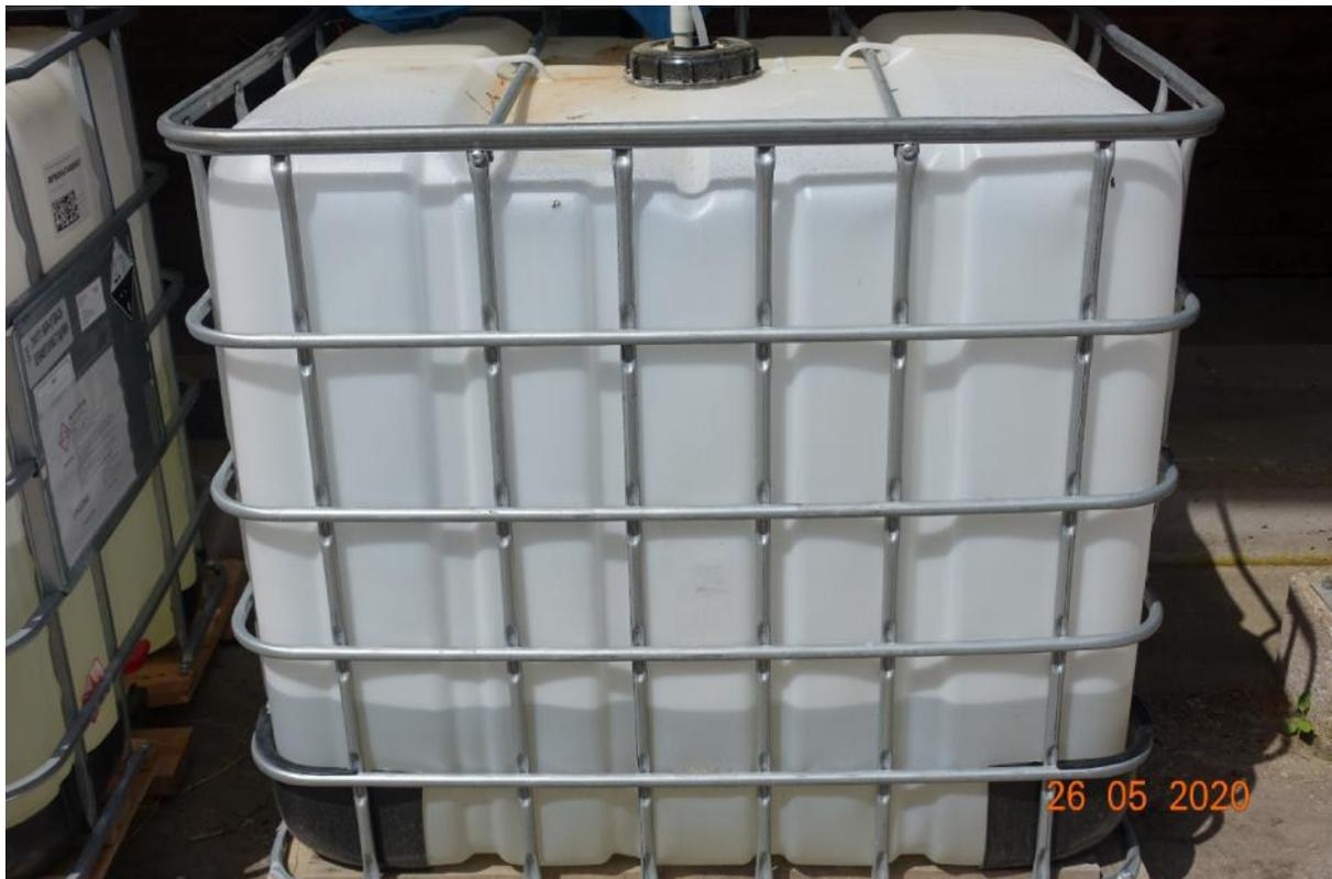
Bild 22: Der 1 m<sup>3</sup> große Fällmittelbehälter müsste nach bisherigem Kenntnisstand 2,5-mal pro Jahr befüllt werden.
