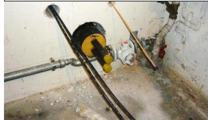
Hausanschlussleitung mit Hauseinführung innen
