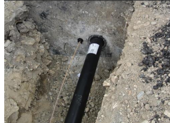
Hausanschlussleitung mit Hauseinführung innen
