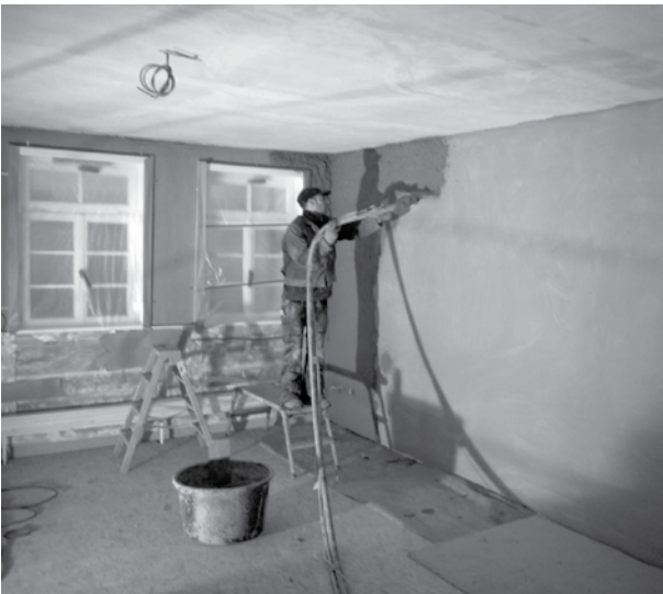
Sanierung mit Lehm
