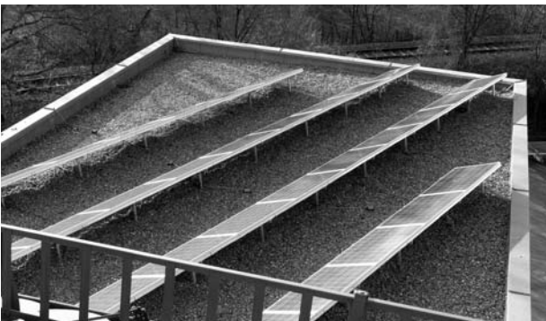
PV-Anlage auf dem Dach der Gymnastikhalle
