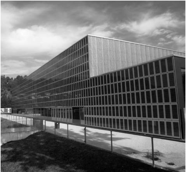
Photovoltaikfassade der Paul-Horn-Arena Tübingen
