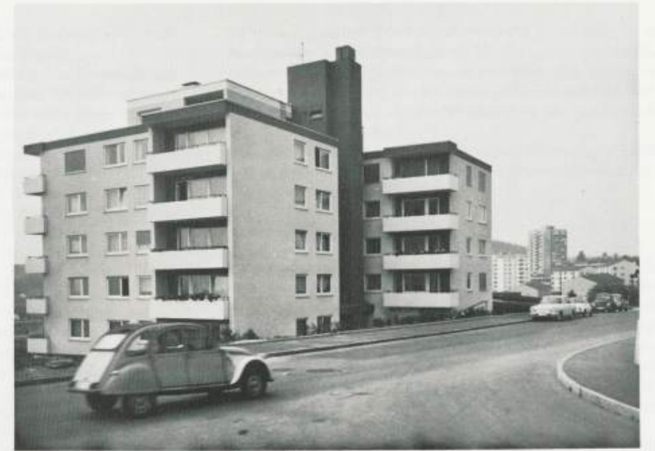
Fernheizwerk auf dem Horemer
