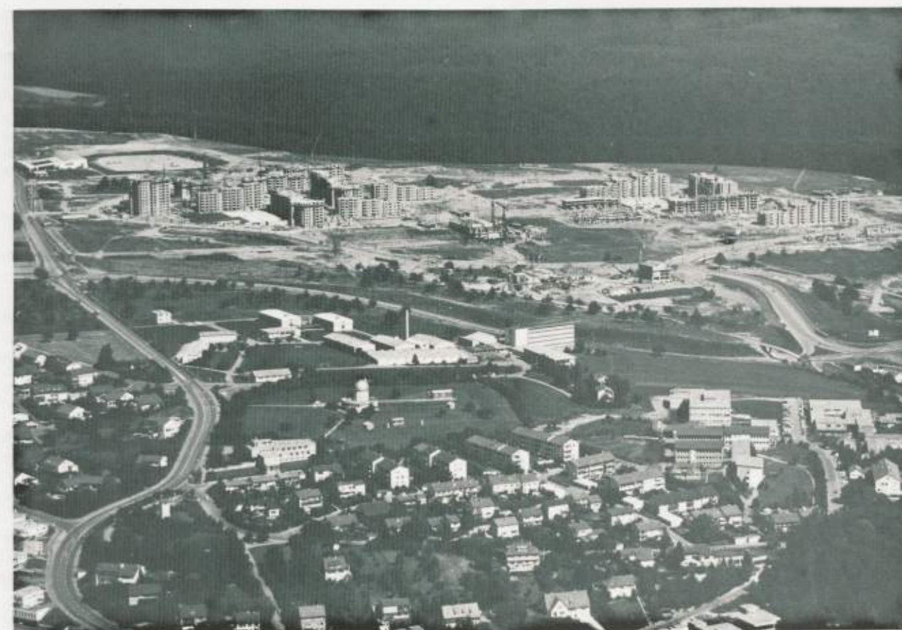
Die Großbaustelle auf dem Gelände des ehemaligen Exerzierplatzes Waldhäuser-Ost
