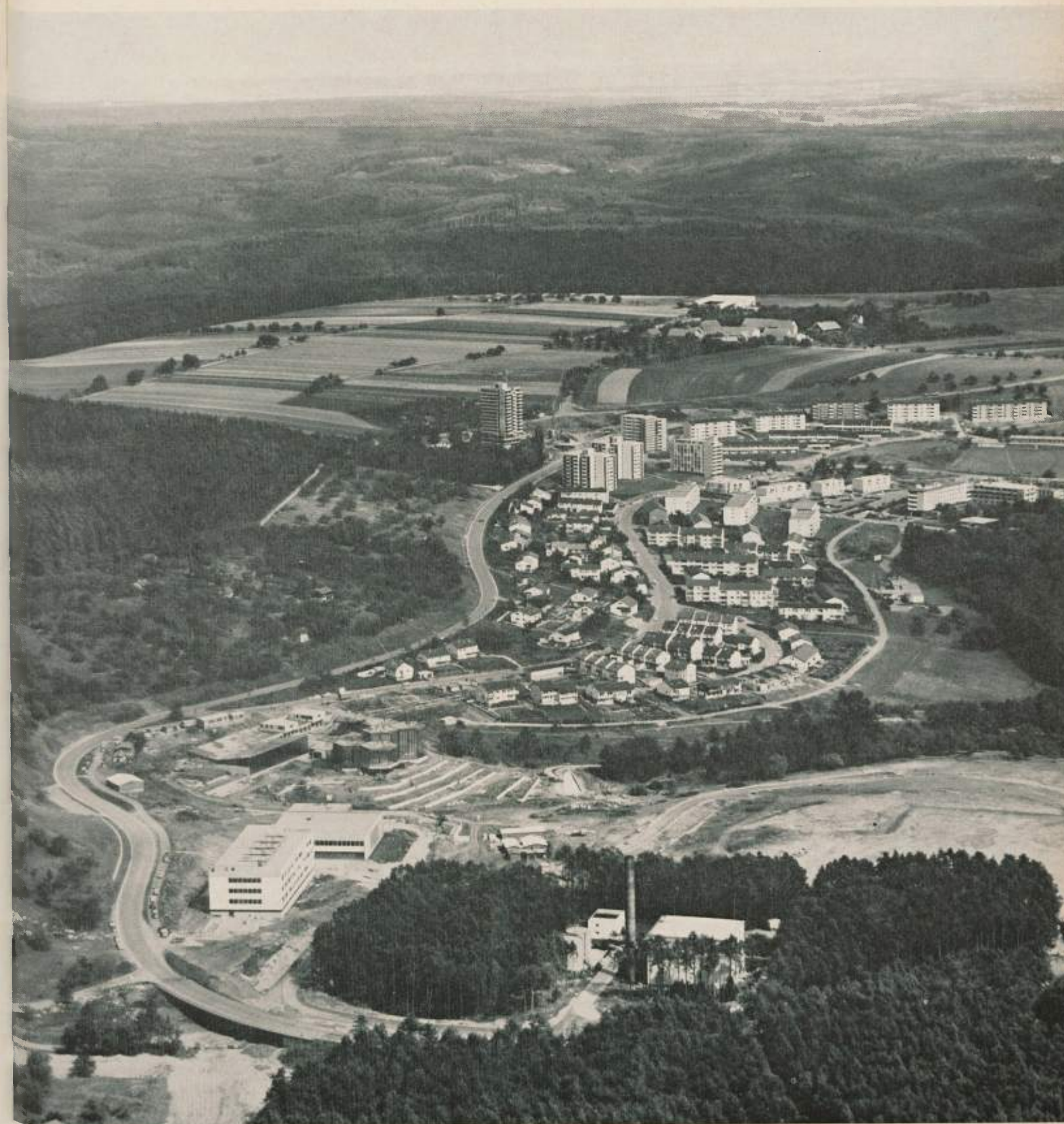
Luftaufnahme vom Neubaugebiet »Wanne«. Die ersten Wohnungen wurden am 1. 8. 1961 bezogen
