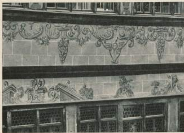
Im Oktober 1963 wurde die Probestaurierung an der Ostfassade des Rathauses abgeschlossen. Nach längeren Beratungen entschied sich der Gemeinderat für die Beibehaltung der Dollinger'schen Fassade. Die Umbauarbeiten im Rathaus, die der Erneuerung der Fassade vorangehen müssen, sind noch im Gange
