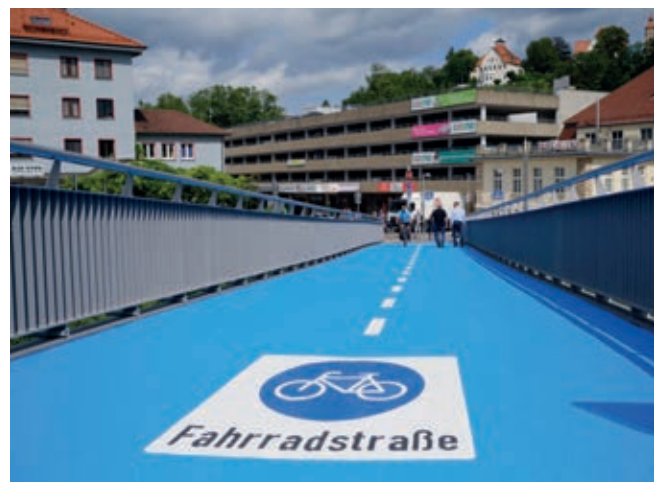
Die Radbrücke Mitte ist beheizbar und damit auch im Winter gefahrlos zu nutzen. Bild: Thomas Dinges
