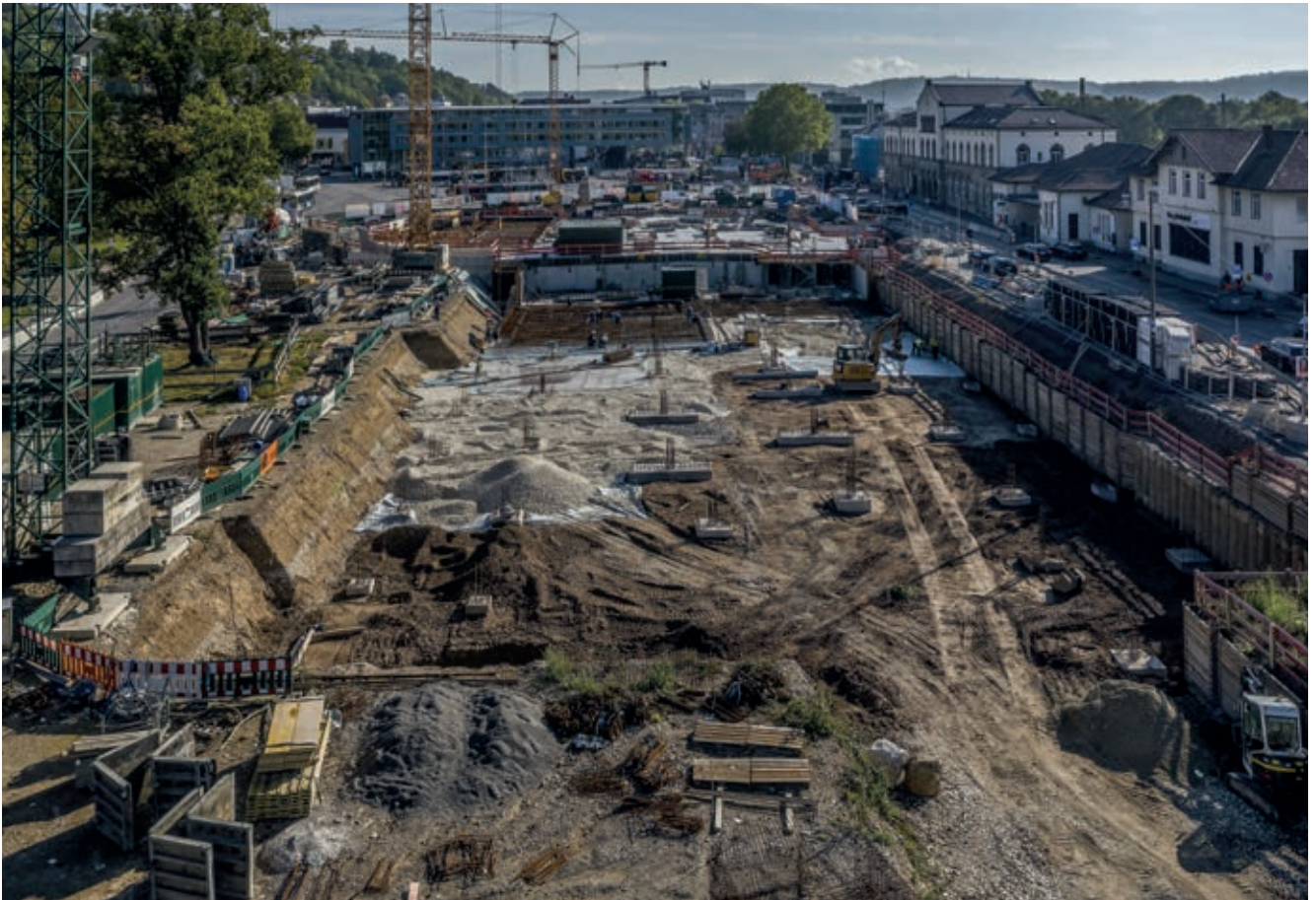
Bauarbeiten am Europaplatz im September 2021. Bild: Ulrich Metz
