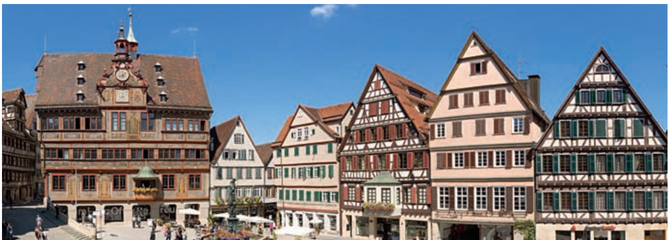
Ein Teil der städtischen Dienststellen ist im Rathaus am Markt untergebracht. Es stammt aus dem Jahr 1435 und wurde zuletzt zwischen 2012 und 2016 saniert. Bild: Alexander Gonschior
