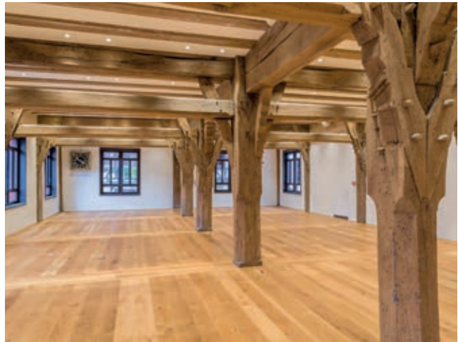
Der Ratssaal im sanierten Rathaus am Markt. Bild: Gerd Jütten Fotodesign
