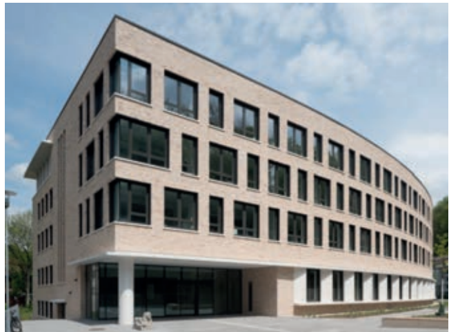
Das erweiterte und sanierte Technische Rathaus in der Südansicht. Bild: Marcus Ebener
