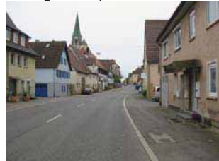
Fahrbahn mit Mittelmarkierung
