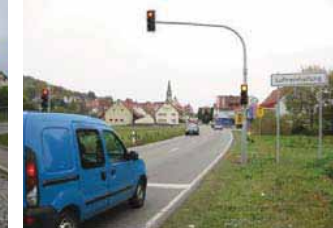
fehlender Übergang zum Radweg
