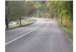
ehem. Radverkehrsführung nicht mehr zu erkennen
