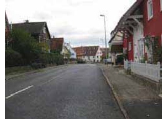
Fahrbahnquerung ohne Radverkehrsfl.
