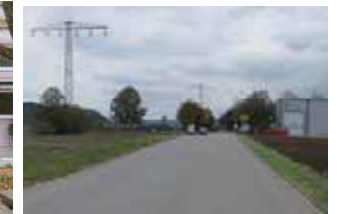
breite Fahrbahn im Industriegebiet
