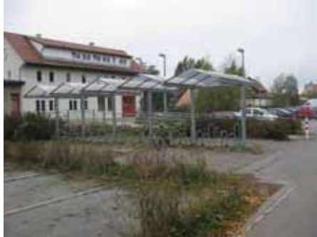
Blickrichtung Westen (B+R am westlichen Zugang)
