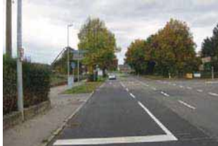
Radweg ohne Überleitung auf die Fahrbahn
