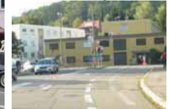
Verblasster Radfahrstreifen am Knotenpkt.
