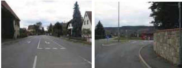
keine Radverkehrsführung im Knotenpunkt und den Zufahrtsarmen
