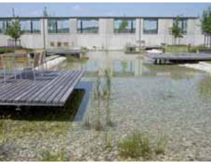
Neu angelegter Regenwasserteich im BMW Werk Dingolfing, Garnhartner, Schober, Spörl, Landschaftsarchitekten, Deggendorf
