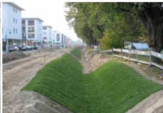
Bau einer Versickerungsmulde, Röhrichtpflanzen stellen sich von selbst ein (Quartier Vauban, Freiburg).
