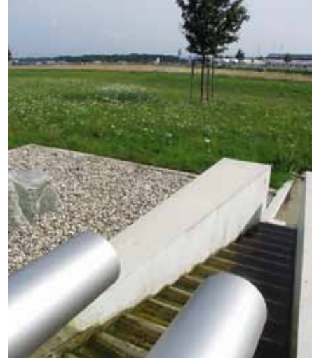
Der Austritt des Dachwassers wurde architektonisch akzentuiert und ergießt sich direkt in die Sickermulde; Universitätscampus der 15. Fakultät in Freiburg
