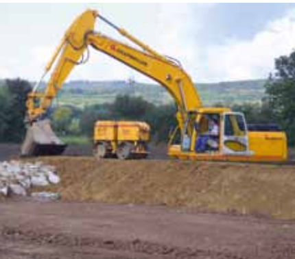
Der Bagger macht die Erdarbeiten für die neue Regenwasseranlage.
