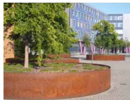
Auf einer Tiefgarage lassen sich Bäume nur in erhöhten Baumquartieren pflanzen, hier aus Cortenstahl (Esplanade Karlsruhe).
