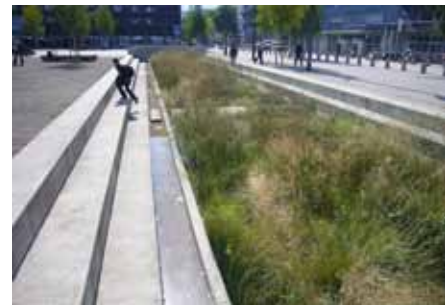
Turbinenplatz Zürich: Die Sickermulde ist gestalterisch in den Platz integriert; ADR Sàrl Architekten, Genf
