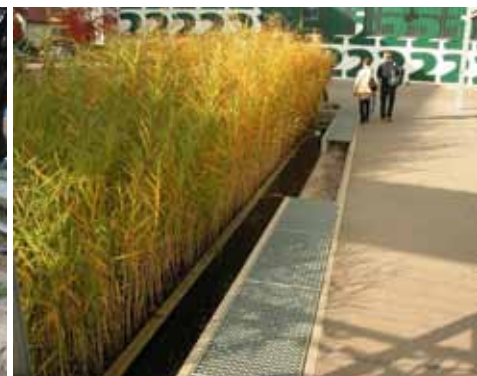
Rinnen speisen ein Schilfbeet, hier wird das Oberflächenwasser gereinigt und versickert (Zürich).
