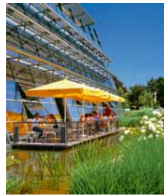
Solar-Fabrik AG, Freiburg Das Holzdeck der Cafeteria „schwebt“ über dem Regenwasserteich.
