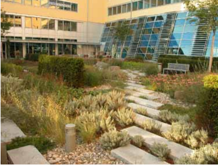
Solar-Info-Center, Freiburg: Intensiv beplanzter Dachgarten auf einer Tiefgarage
