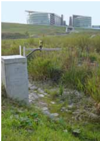
Das Oberflächenwasser der Neuen Messe Stuttgart versickert in einem Bodenfilterbecken und speist das Grundwasser.
