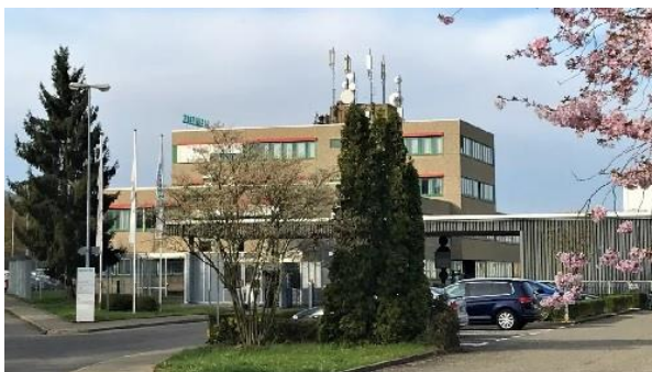
Bild: Siemens Kilchberg
