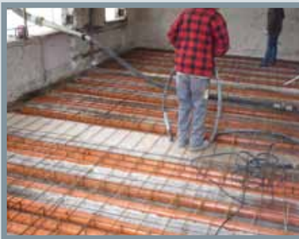
Die Franzosen hatten in den Geschossdecken Bims verbaut. Ersetzt wurde dieser durch Stahlbeton, in den man Leerrohre einarbeitete, um das Gewicht zu begrenzen.
