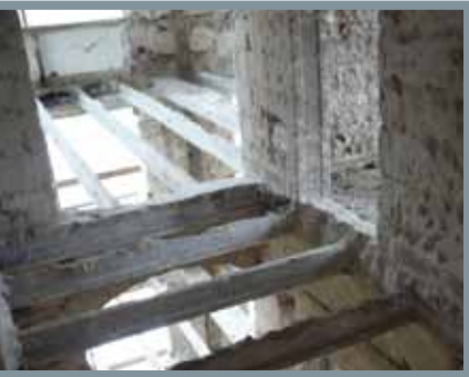
Die schwierigste Sanierung war der Querbau am Janusz-Korczak-Weg 1/3: Neue Vorschriften forderten eine höhere Erdbebensicherheit. Hierfür mussten die Geschossdecken erneuert werden.
