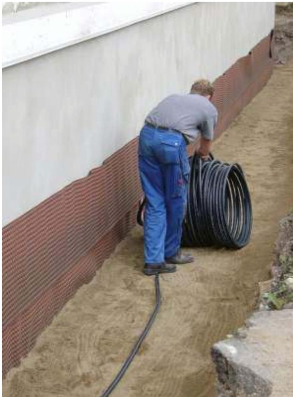
Verlegung der Kunststoffrohre des S-EWT
