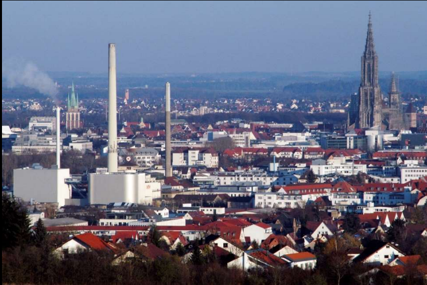
Fernwärme Ulm GmbH
