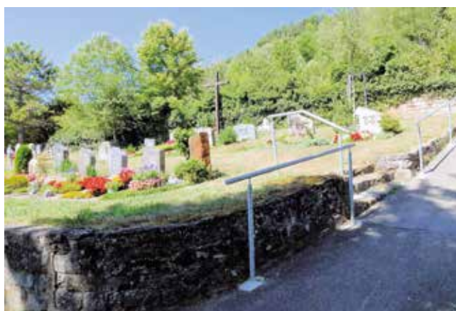
Handläufe nach den Baumaßnahmen. Bild: Karl Fischer
