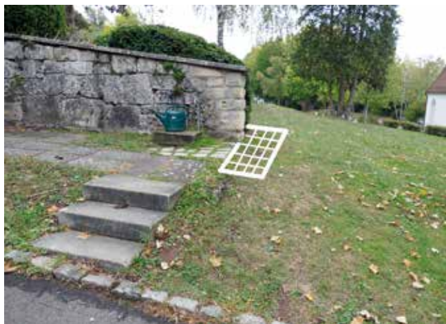
Die Wasser-Entnahmestelle vorher, mit der Markierung, was verbessert werden muss. Bild: Karl Fischer
