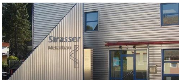
Bild: Strasser Metallbau GmbH
