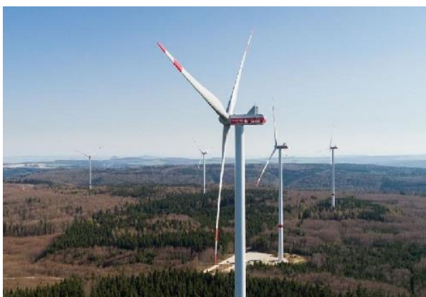
Windpark Amtenhauser Berg; Bild: swt/Marquardt
