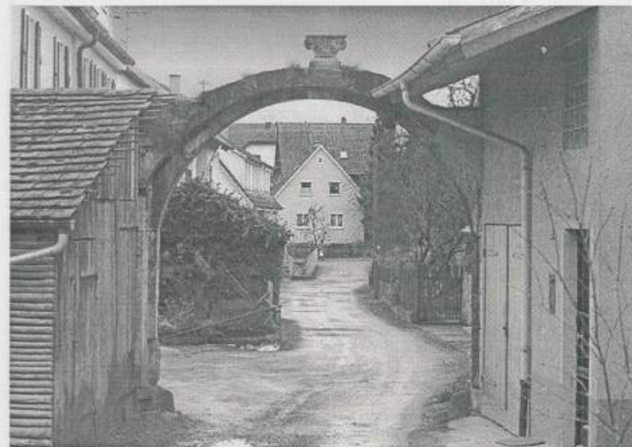
Torbogenweg mit Torbogen vor der Sanierung
