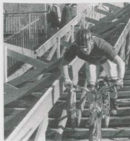
Treppenabgang zur Platanenallee: aus Geldmangel verschobene Sanierung (14.9.94)
