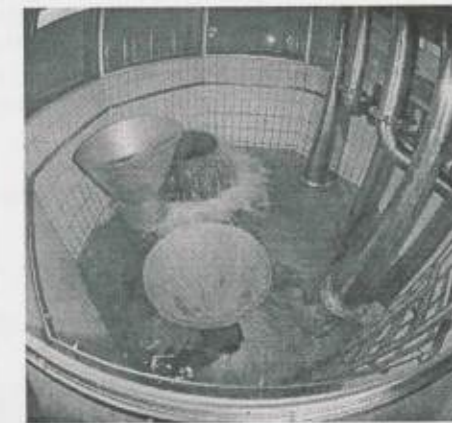
Durch die Mischung von Eigen- und Bodenseewasser im Behälter Sand erhalten fast alle Tübinger Haushalte Wasser im Härtebereich 2 (7-14° dH)
