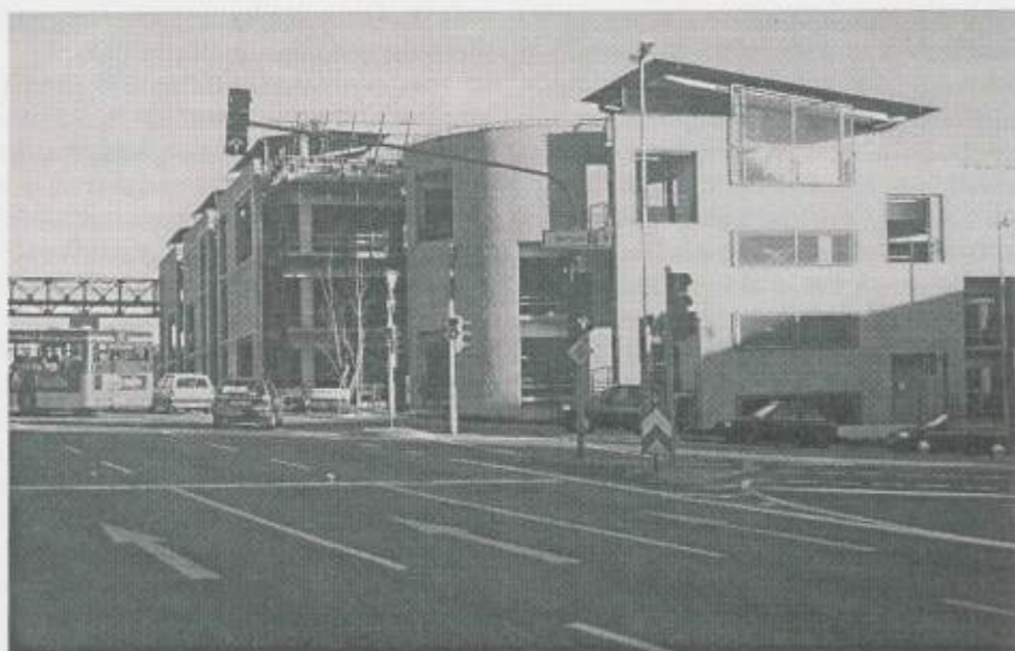
Parkhaus Metropol in der Bauphase
