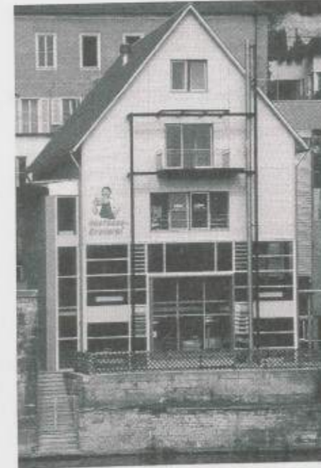
Neubau der Neckarmüllerei (30.9.92)
