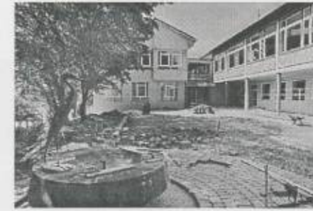
Grundschule Unterjesingen: Erweiterungsbau
