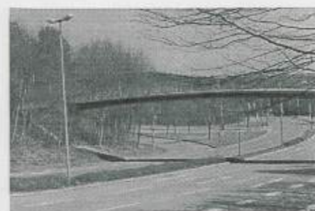
Sanierung Fußgängerbrücke Nordring
