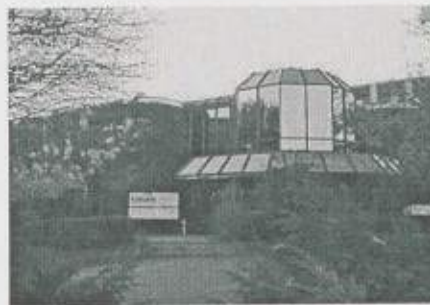
Derendingen, Gewerbegebiet "Unter dem Holz": Neubau der Firma Transtec
