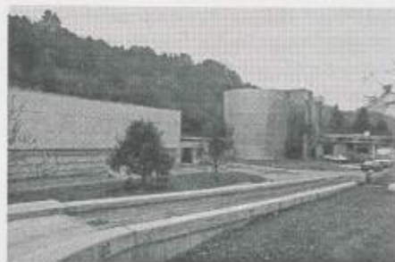
Ausbau und Erweiterung: Klärwerk im Neckartal
