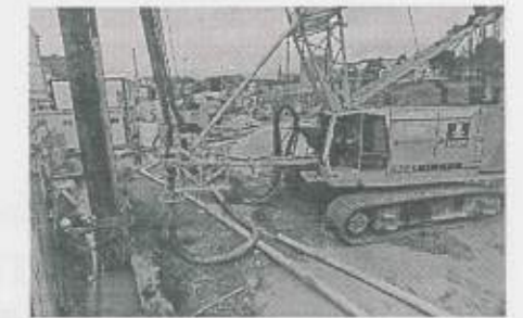
Parkhaus Metropal: Altlastensanierung auf dem ehemaligen Gaswerk-Gelände
