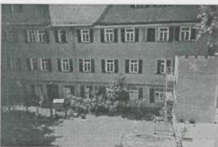
Sanierungsbedürftig: das Bürgerheim
