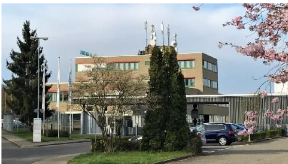
Bild: Siemens Kilchberg
