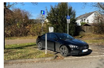
Abb. 34: Ladeinfrastruktur in der Primus-Truber-Straße
