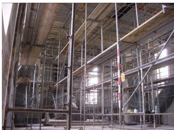
Bild: Härer Gerüst- und Bühnenbau
