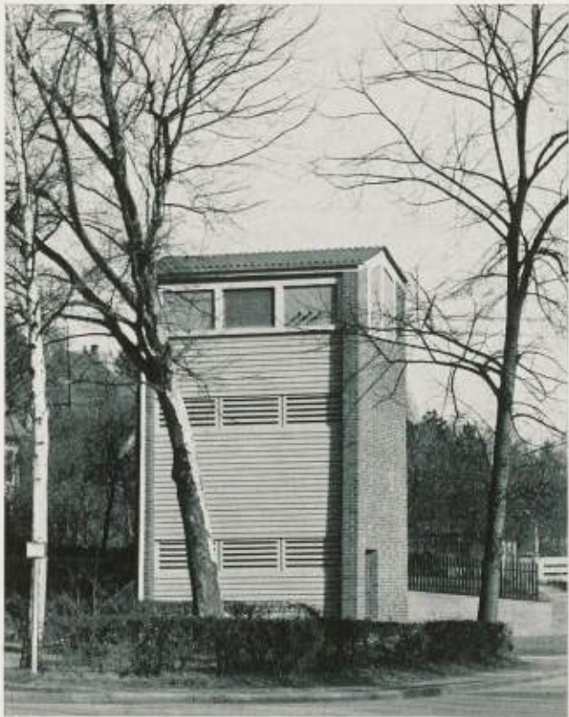
Transformatorstation beim Pauline-Krone-Heim
