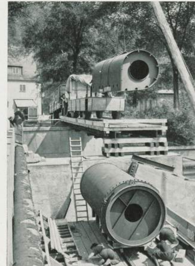
Neue Wehrwalzen am Elektrizitätswerk Brückenstraße
