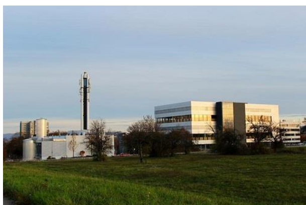
BHKW Obere Viehweide; Archivbild: swt/Schermaul
