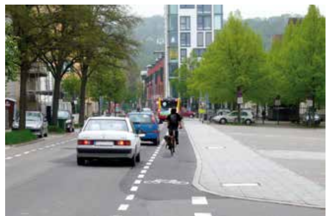
2013 wurde ein Schutzstreifen für Radfahrende in der Keltnerstraße eingerichtet. Bild: Universitätsstadt Tübingen
