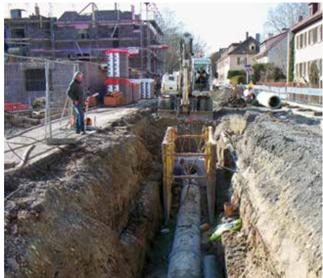
Im Untergrund der Straßen verlaufen viele Leitungen. Wenn aufgedrungen werden muss, werden die Arbeiten mit den Stadtwerken abgestimmt, die für Strom- und Gasleitungen verantwortlich sind. Bild: Universitätsstadt Tübingen
