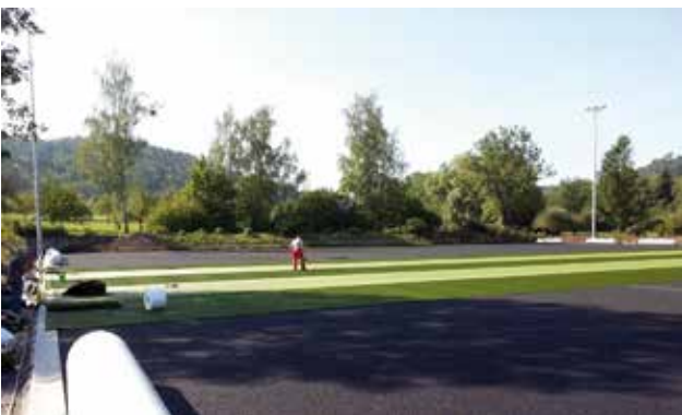
Der Sportplatz Bühl wurde 2014 fertig und kostete 1 Million Euro. Bild: Universitätsstadt Tübingen
