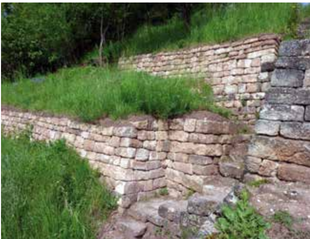
Trockenmauer-Sanierung am Hirschauer Berg für das städtische Ökokonto. Bild: Universitätsstadt Tübingen
