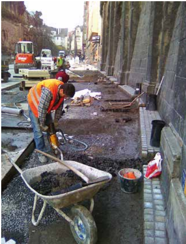
Die Bauarbeiter bereiten den Untergrund für den Gehweg in der Mühlstraße vor. Bild: Universitätsstadt Tübingen
