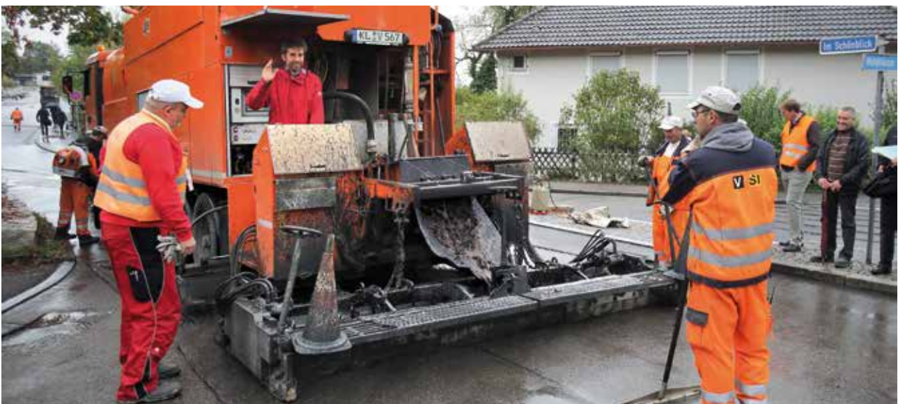
Im Oktober 2013 wurde die Straße Im Schönblick mit dem neuen Dünnschichtverfahren saniert. Bild: Erich Sommer
