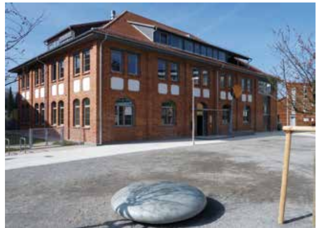
Das Kinderhaus Mühlenviertel, der Mittelpunkt des neuen Quartiers, untergebracht in einem sanierten Industriegebäude. Bild: Universitätsstadt Tübingen
