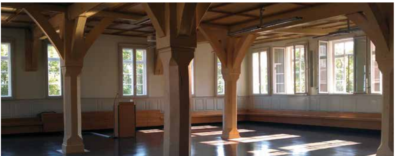
2012 ist die Grundsanierung der Alten Aula nach drei Jahren abgeschlossen. Das Bild zeigt den Veranstaltungssaal im Erdgeschoss. Bild: Universitätsstadt Tübingen
