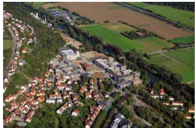
Auf dem ehemaligen Betriebsgelände der Firma Egeria im Stadtteil Lustnau entsteht das neue Quartier Alte Weberei. Bild: Manfred Grohe
