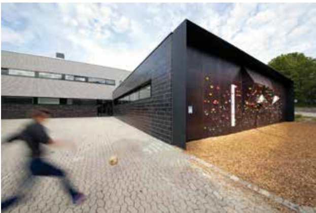
Die Sporthalle Waldhäuser Ost nach der Sanierungsphase 2009 bis 2012, Ostansicht. Bild: Dominik Hatt, Danner Yildiz Architekten Tübingen
