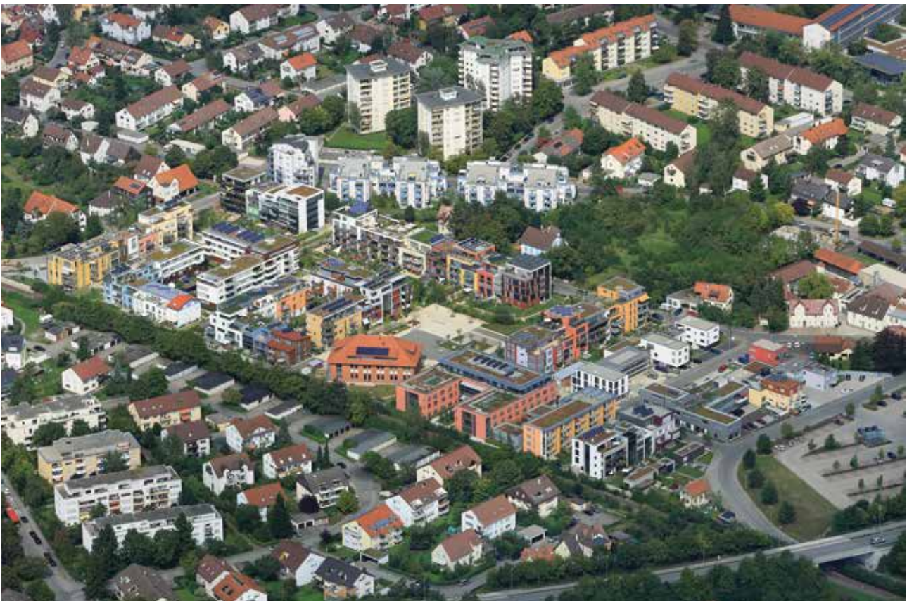
Im rund vier Hektar großen Mühlenviertel in Derendingen ist ein lebendiges und gemischt genutztes Quartier für über 600 Bewohnerinnen und Bewohner entstanden. Luftbild: Manfred Grohe
