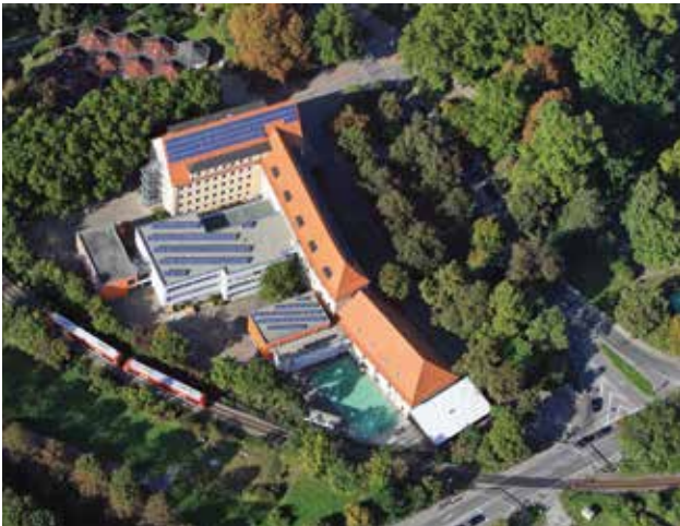
Solarzellen auf dem Dach des Wildermuth-Gymnasiums wandeln seit einer Sanierung Sonnenlicht in elektrische Energie um. Bild: Manfred Grohe
