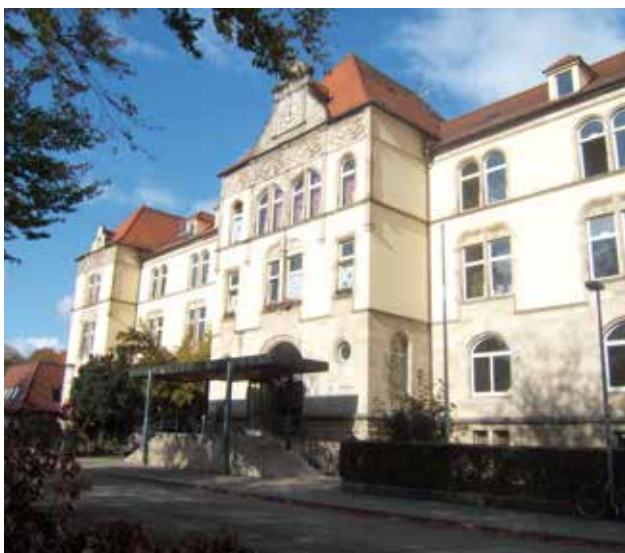
Der sanierungsbedürftige Altbau des Uhland-Gymnasiums in einer Aufnahme von 2007. Bild: Universitätsstadt Tübingen
