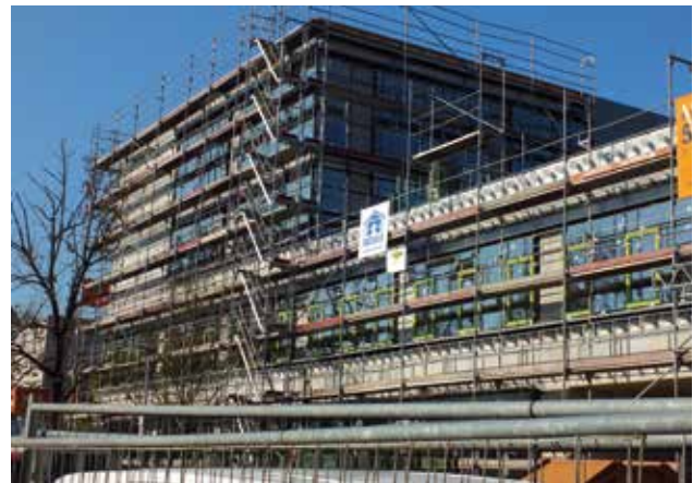
Der Erweiterungsbau für das Uhland-Gymnasium steht 2013 im Rohbau. Bild: Universitätsstadt Tübingen
