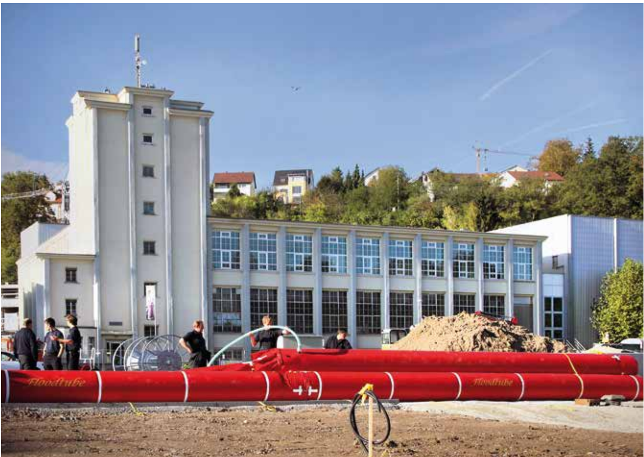
Seit Oktober 2013 steht ein mobiles Schutzsystem aus roten Schläuchen bereit: Es soll im Hochwasserfall das Gebiet um die Alte Weberei schützen. Bild: Erich Sommer
