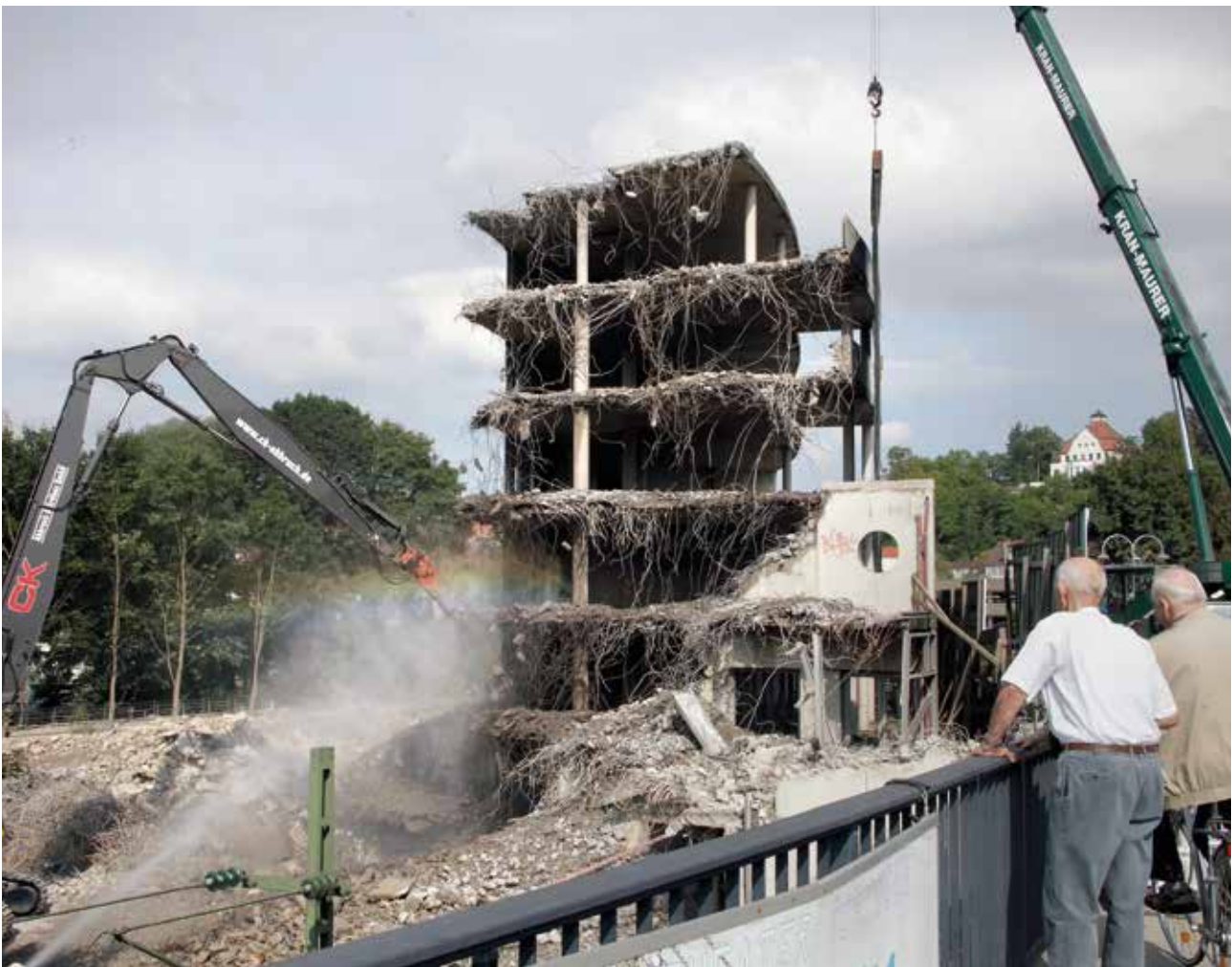
Abriss der Bauruine am Foyer. Bild: Erich Sommer
