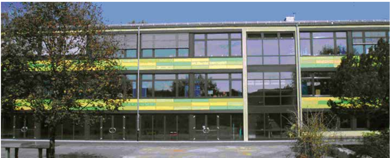
Frisch saniert: die Grundschule Pfrondorf. Bild: Universitätsstadt Tübingen
