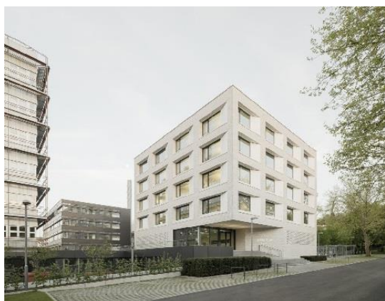
Bild: SüdWestStrom /B. González
