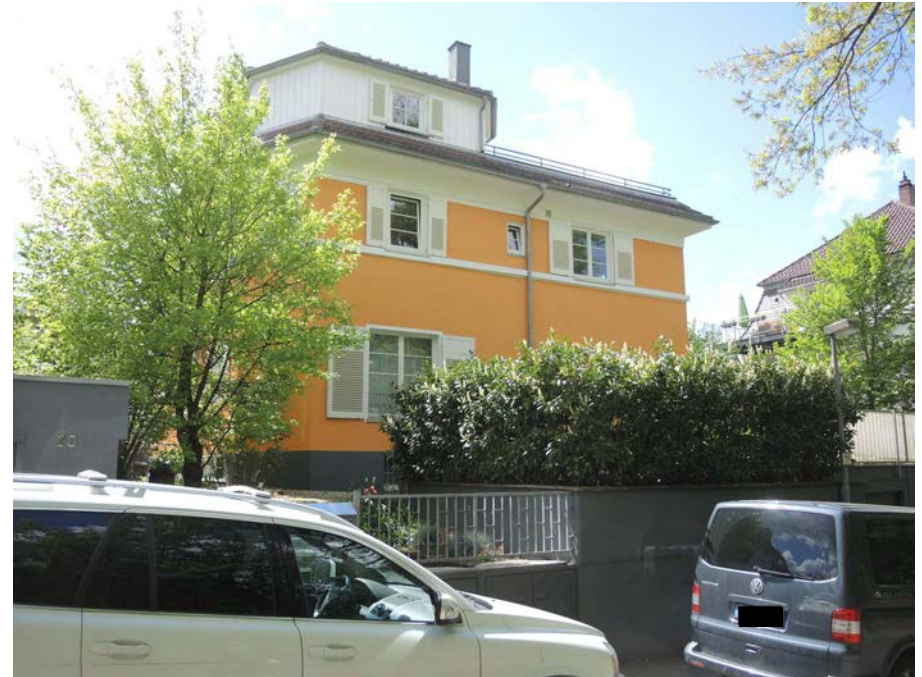
Ansicht des Gebäudes von Osten
