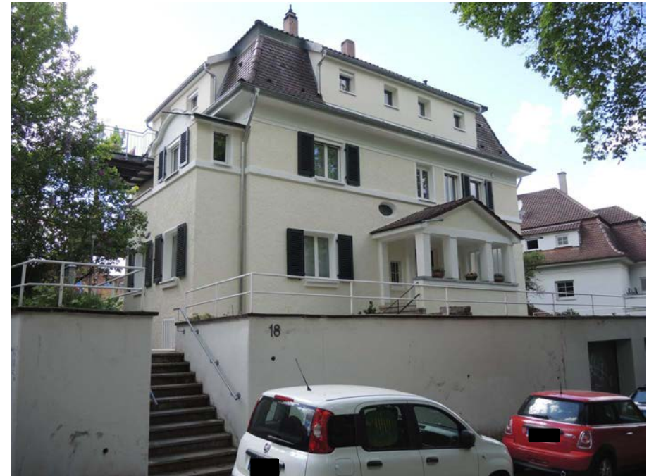
Ansicht des Gebäudes von Osten
