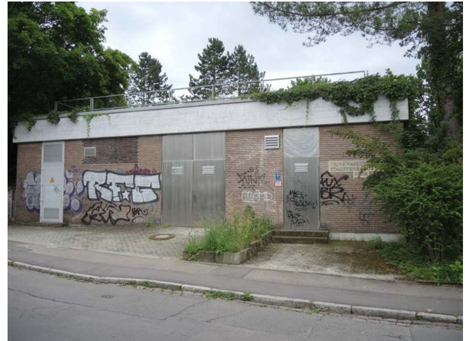
Ansicht des Wasserbehälters von Nordwesten
