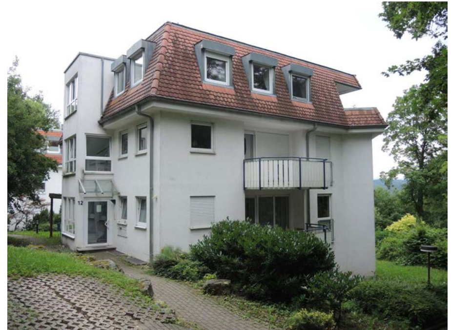
Ansicht des Wohngebäudes von Westen
