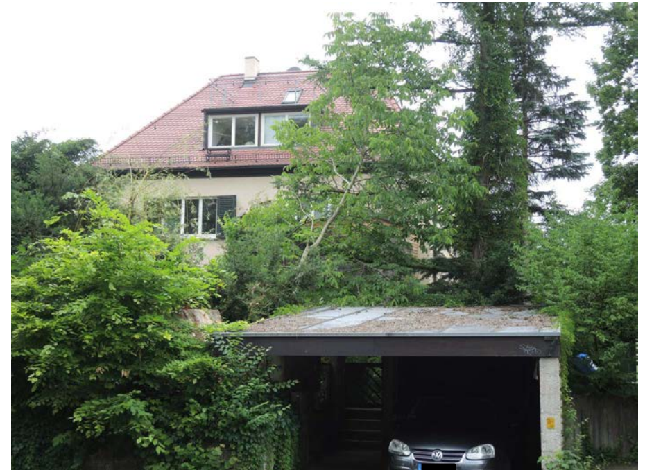
Ansicht des Wohngebäudes von Südosten
