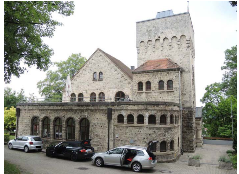
Ansicht des Verbindungshauses von Nordwesten
