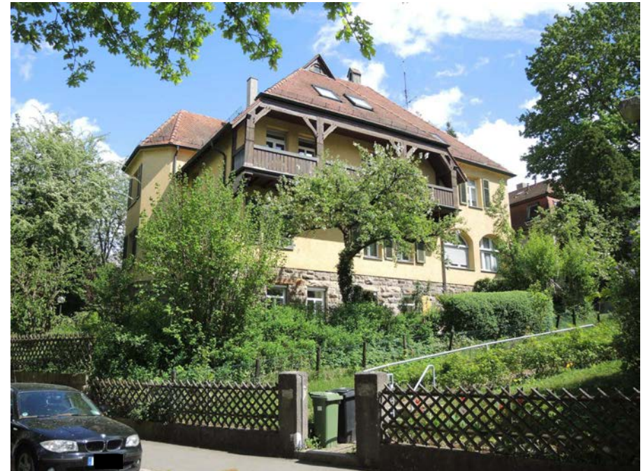
Ansicht des Wohngebäudes von Westen
