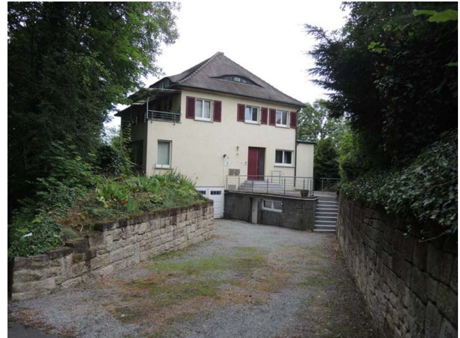
Ansicht des Gebäudes von Südosten
