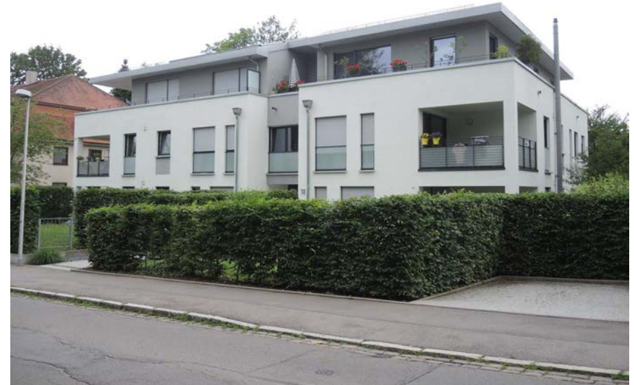
Ansicht des Wohngebäudes von Südosten
