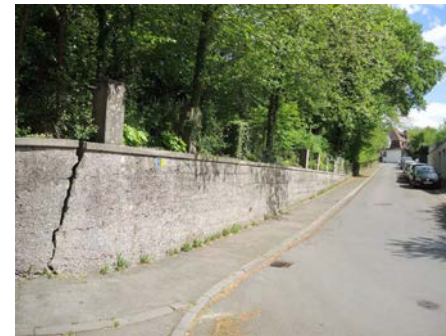
Ansicht der Garteneinfriedung an der Straße
