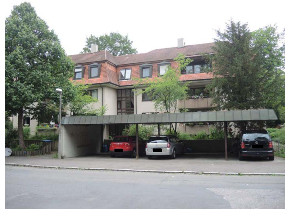
Ansicht des Wohngebäudes von Südosten
