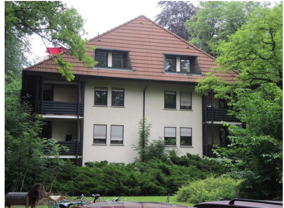
Ansicht des Wohngebäudes von Süden
