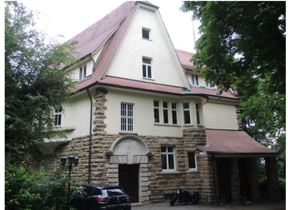
Ansicht des Verbindungshauses von Nordwesten
