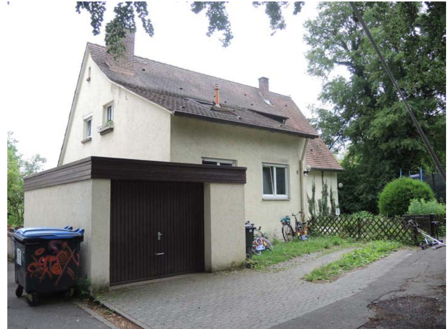
Ansicht des Wohnhauses von Nordosten
