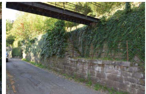
Reste von Weinbergmauern und Staffeln (Foto: Landesamt für Denkmalpflege)
