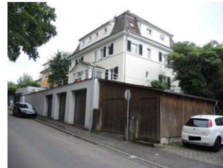
Ansicht von Norden
