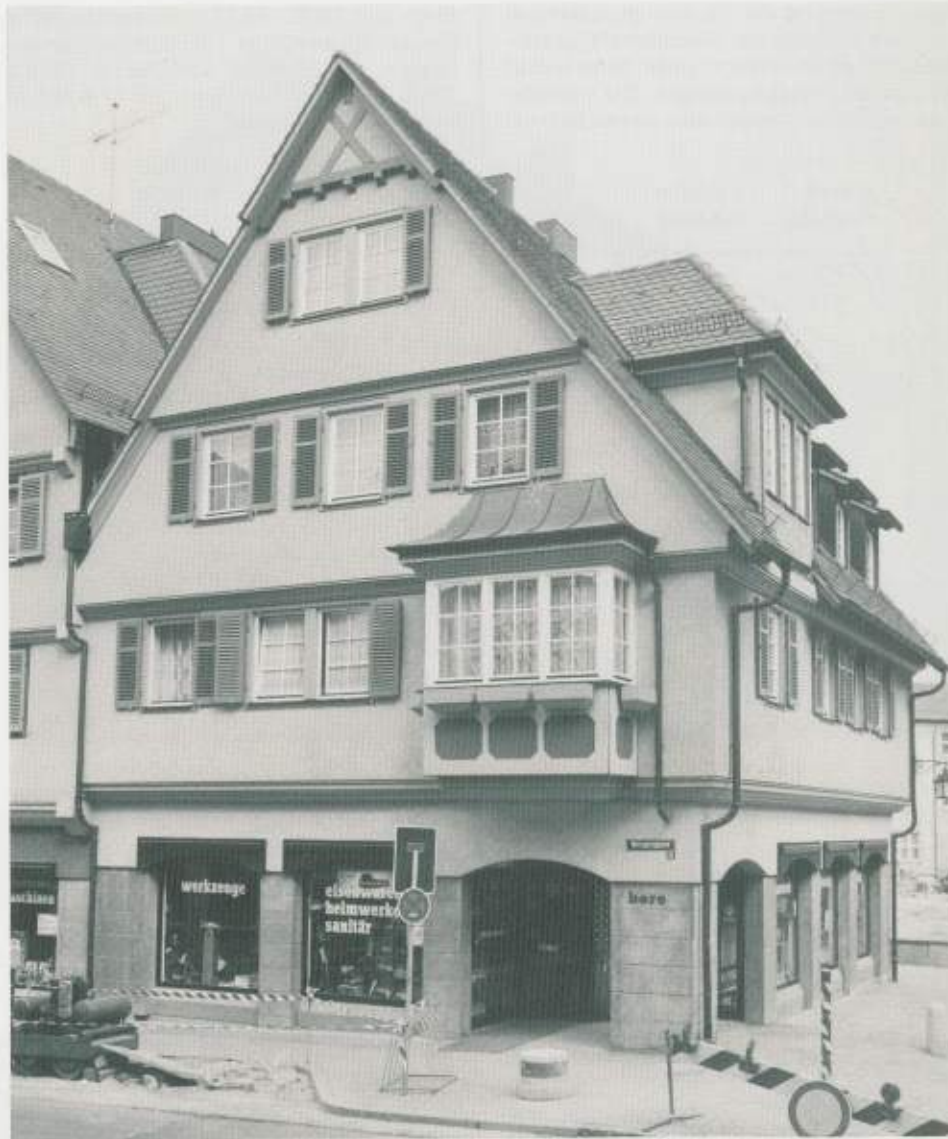
Im Rahmen der Altstadtsanierung: Neubau Metzgergasse 15 (Teilansicht)
