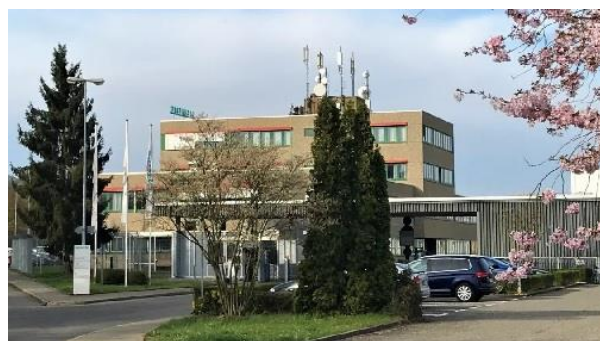
Bild: Siemens Kilchberg
