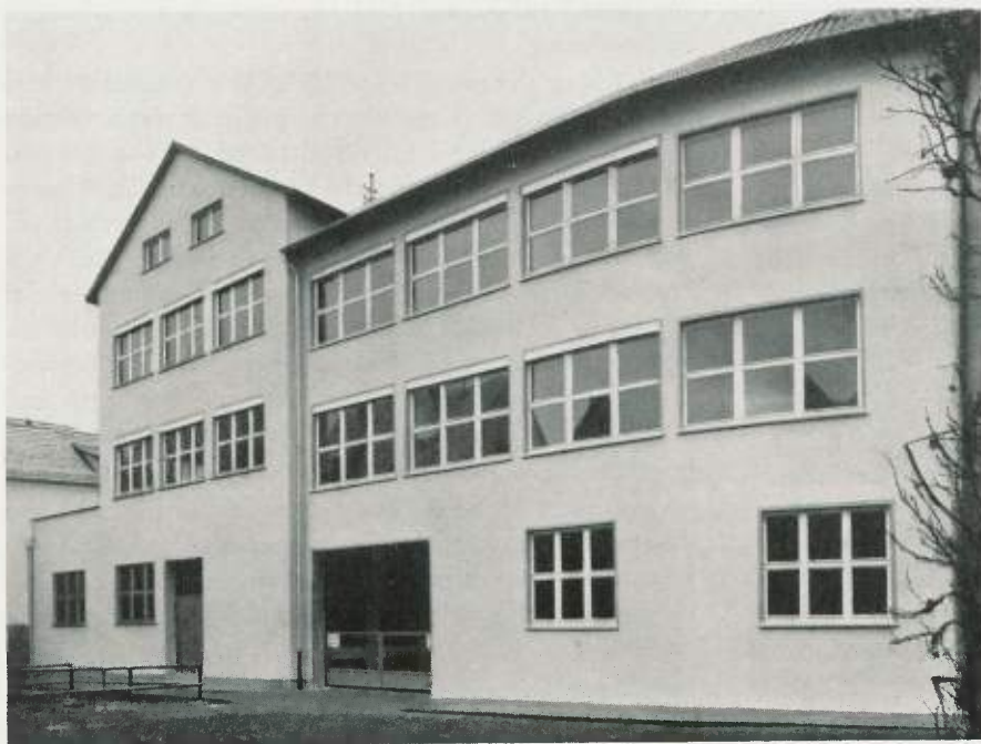
Neubau der Stadtwerke für ein Umspannwerk und die Zählerabteilung
