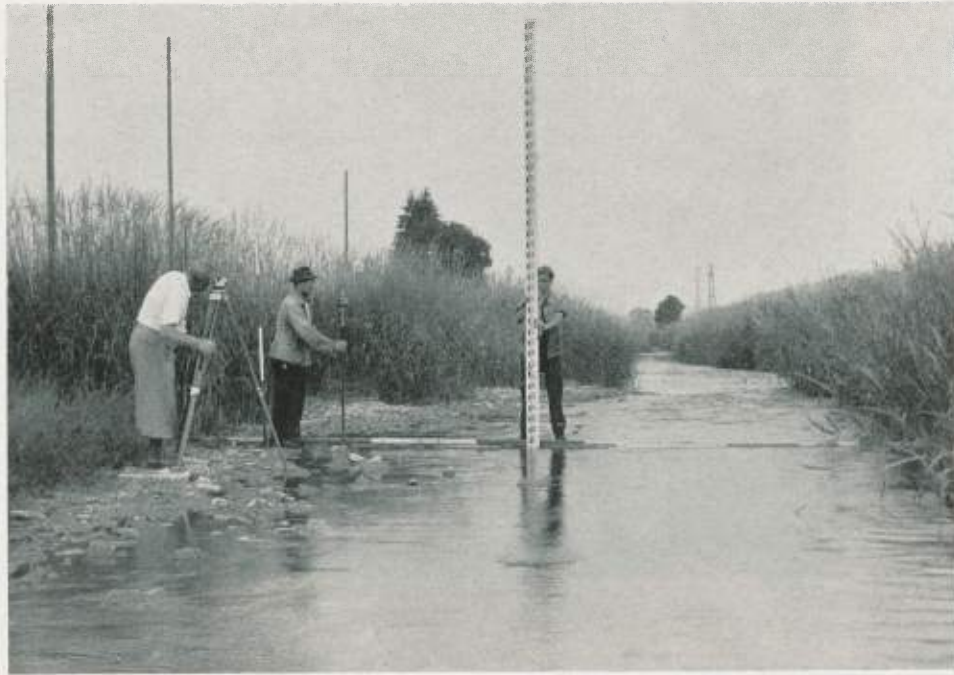
Querschnittsmessungen des Stadtmessungsamtes im Bett der Steinlach
