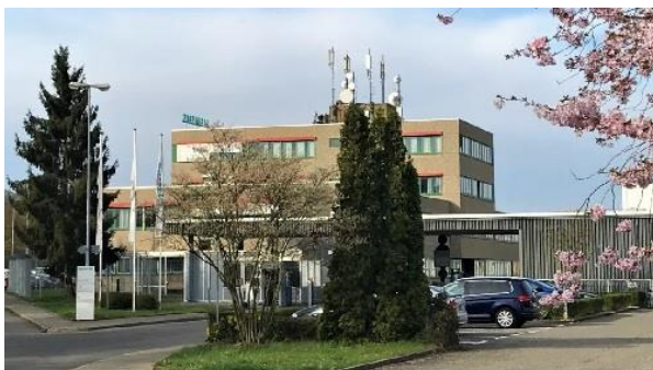
Bild: Siemens Kilchberg
