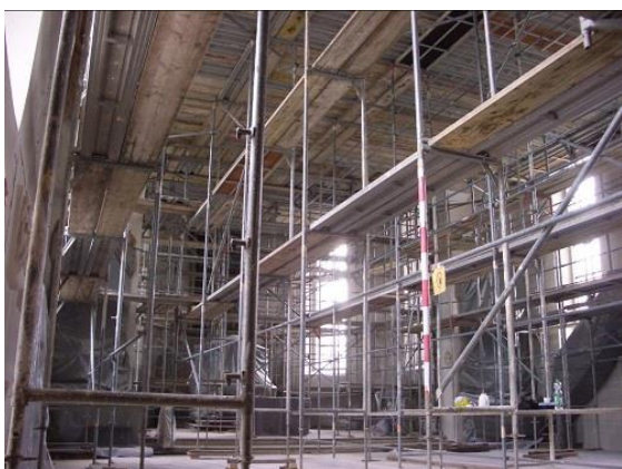
Bild: Härer Gerüst- und Bühnenbau
