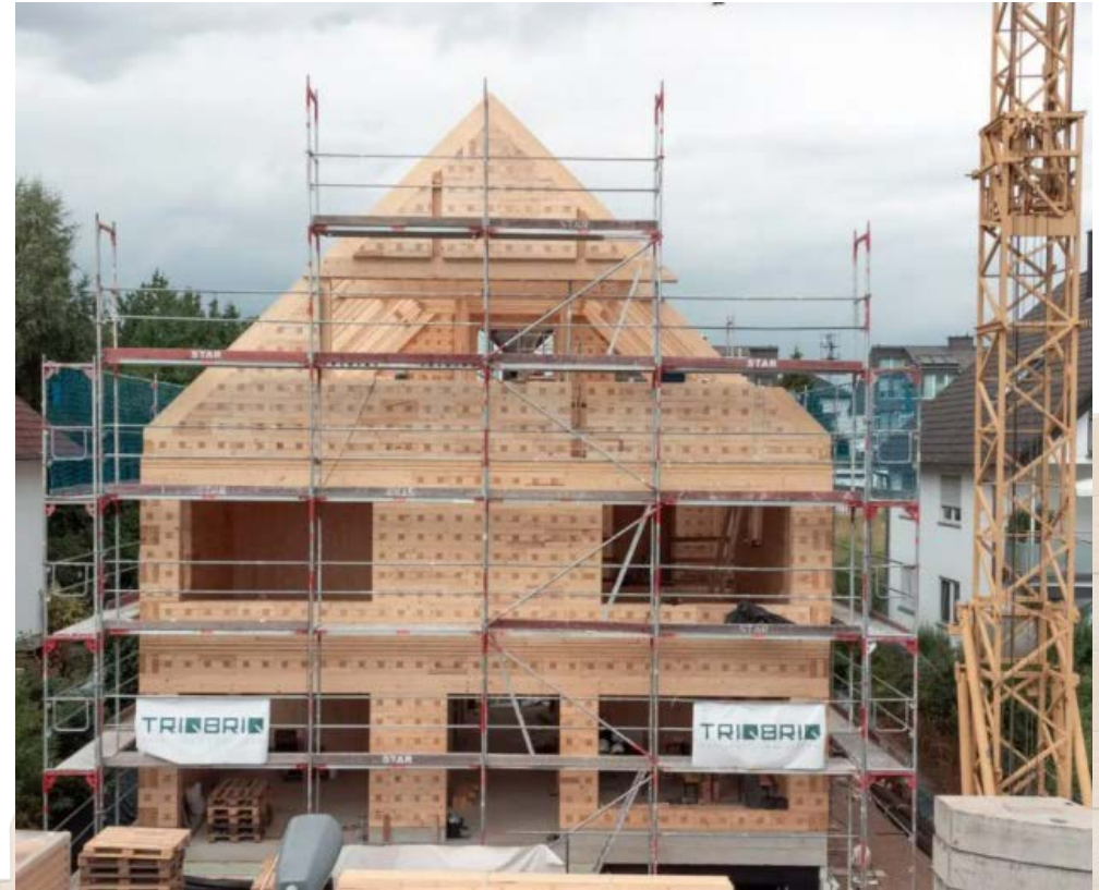
TRIQBRIQ Rohbau in 6 Tagen fertig gestellt
