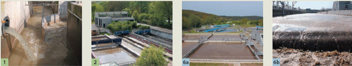
Das Klärwerk Tübingen im Überblick
