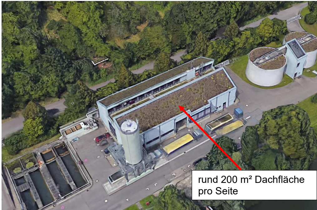
Abb. 49: Luftbild Betriebsgebäude Nord Kläranlage mit bestehender Heizzentrale (Quelle: google earth)
