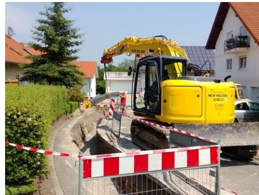
Abb. 37: Verlegung KMR-Rohr
