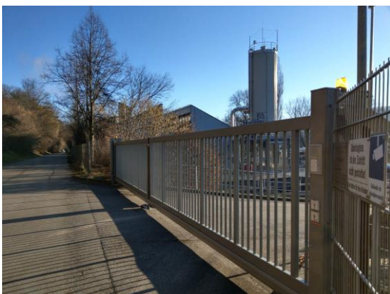
Einfahrt Klärwerk Nürtinger Straße
