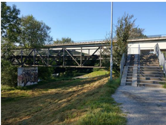
Stuttgarter Straße und Fußverkehrsbrücke
