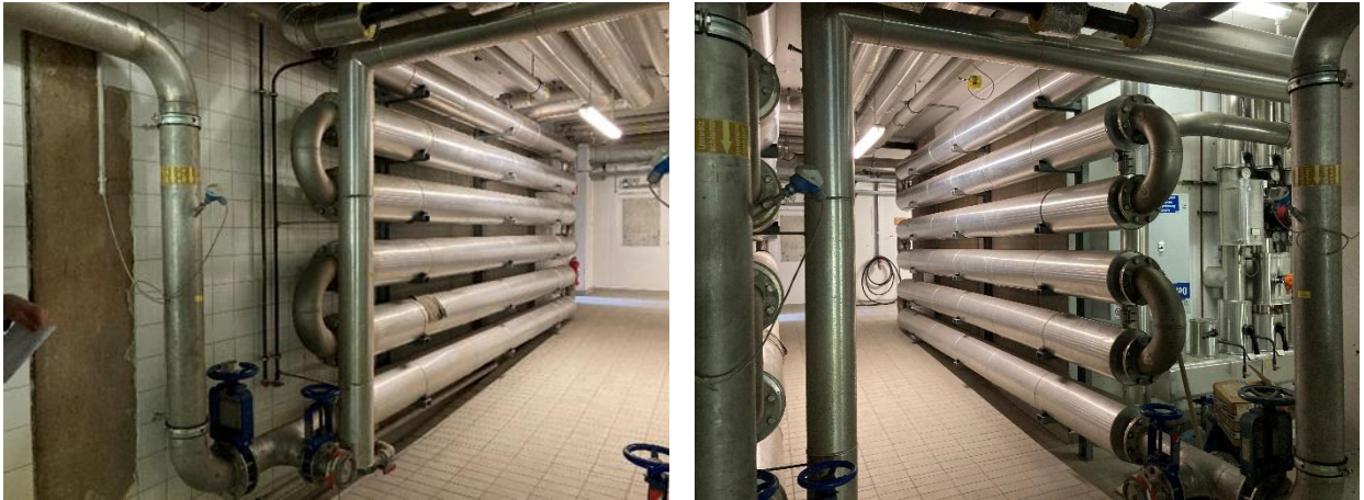
Abb. 43: Klärschlammwärmetauscher
