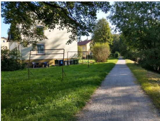
Zeilenbauweise südl. der Gartenstraße
