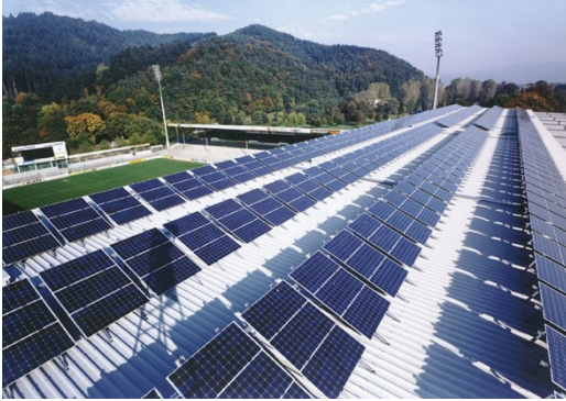
Stadion SC Freiburg
