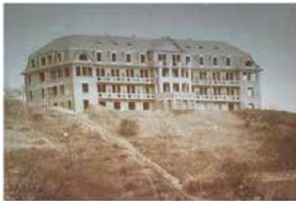
1916: Tropengenesungsheim im Bau
