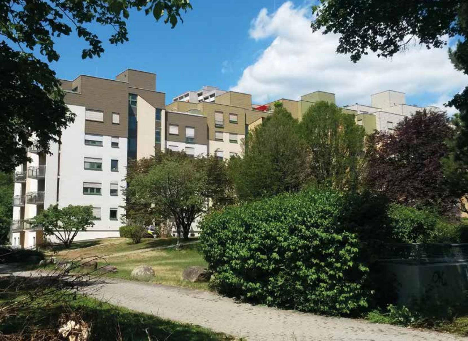
Abb.1: Wohngebäude in Waldhäuser-Ost.
