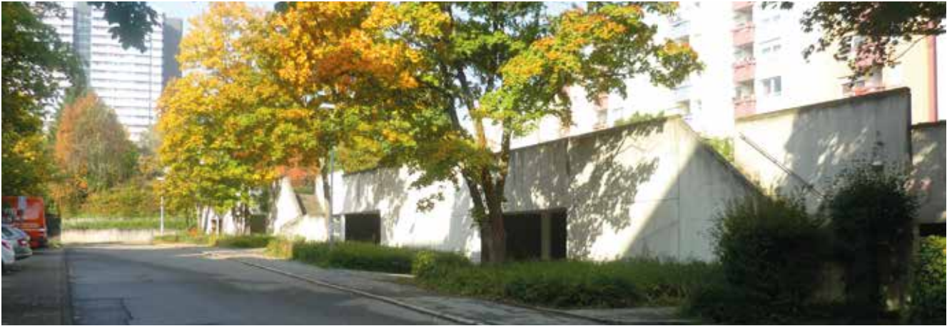
Abb. 43: Tiefgarageneinfahrten in Waldhäuser-Ost
