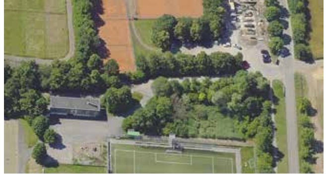
Abb. 112: Eingangsbereich der Sportanlage Holderfeld
