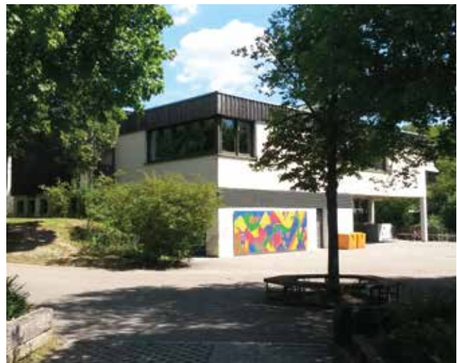
Abb. 28: Grundschule Winkelwiese/Waldhäuser-Ost, Standort Weißdornweg
