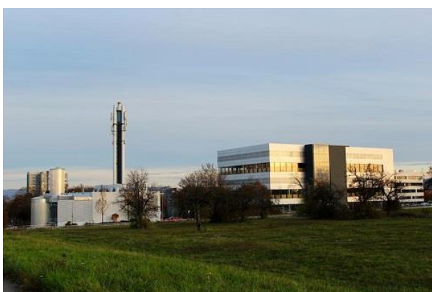
BHKW Obere Viehweide; Archivbild: swt/Schermaul
