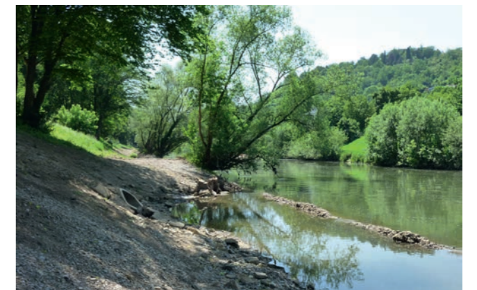
Renaturierung des Neckars auf Höhe des Freibads kurz nach der Fertigstellung.
