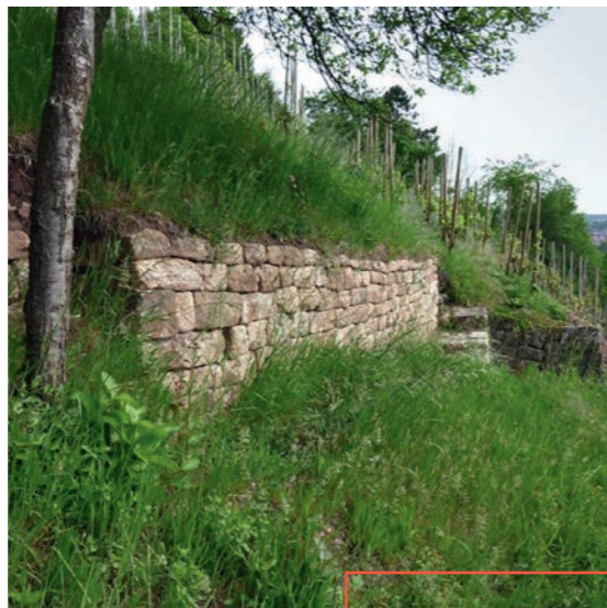
Wiederhergestellte Trockenmauer oberhalb des Hennentalwegs
