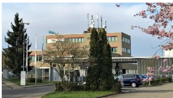
Bild: Siemens Kilchberg
