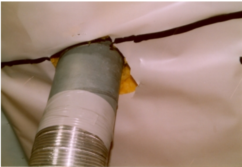
Beispiel einer undichten Durchführung
