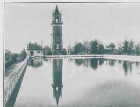
Speicherbecken für die hydraulische Akkumulierung
