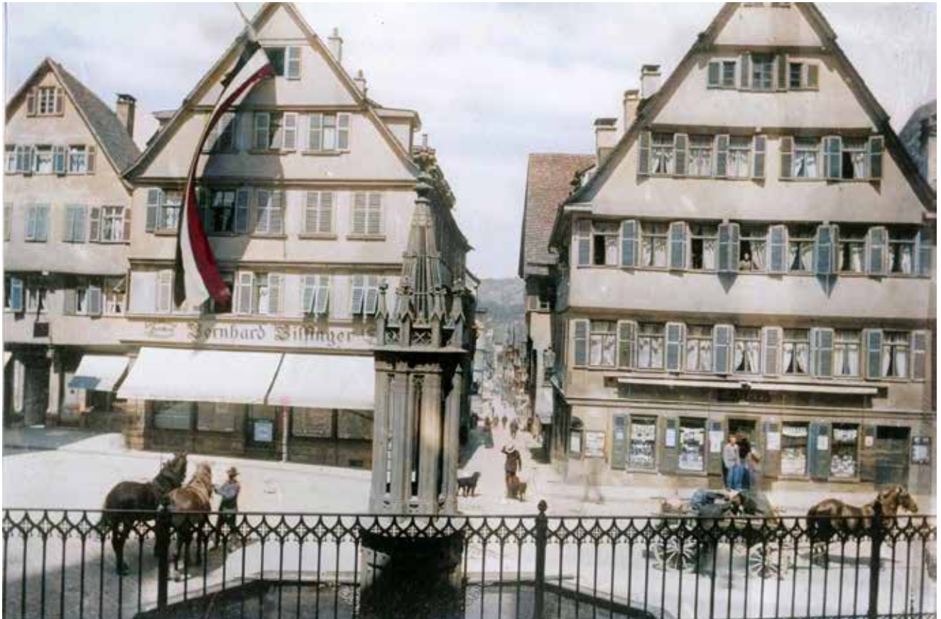
Neogotische Brunnensäule des Georgsbrunnens um 1900. Dahinter das Gebäude Holzmarkt 1 (Foto: Stadtarchiv)
