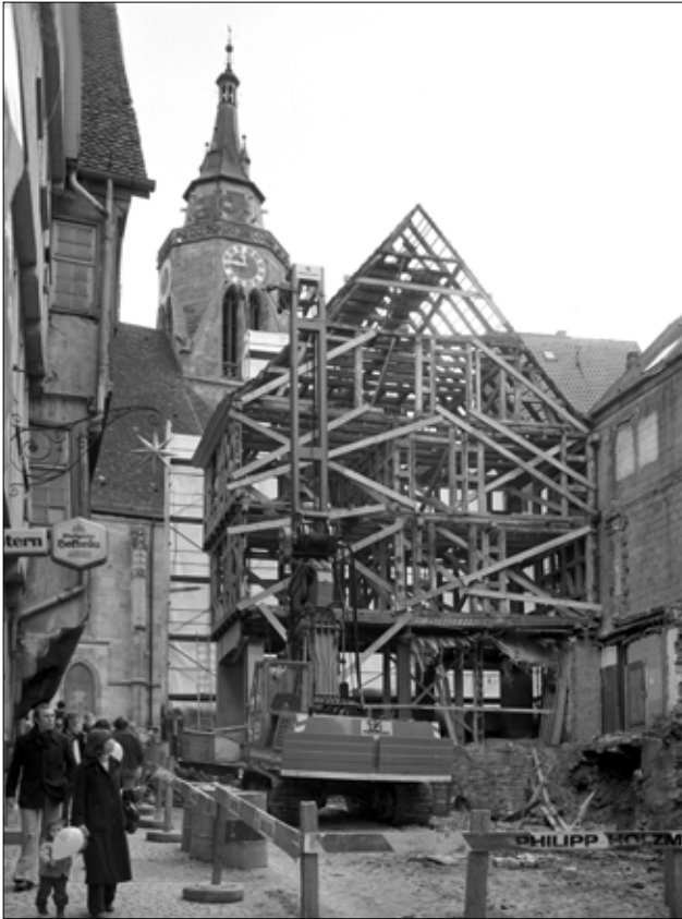
Das Holzskelett des Hauses während des Umbaus 1980 (Foto: Manfred Grohe)
