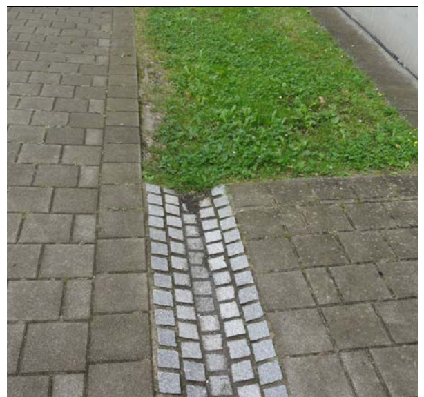
Einfache Maßnahme zur schadlosen Ableitung von Regenwasser
