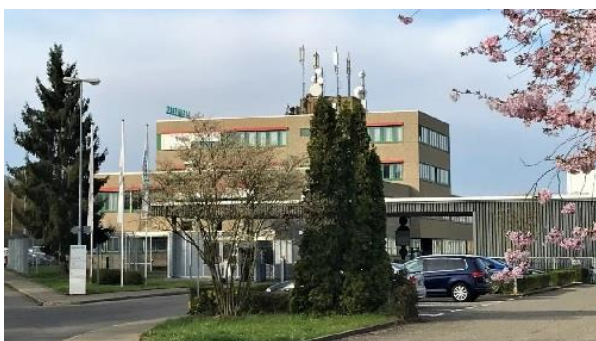
Bild: Siemens Kilchberg
