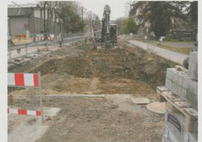
Generalsanierung der Derendinger Straße
