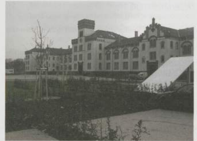
Die Thiepval-Kaserne nach der Renovierung
