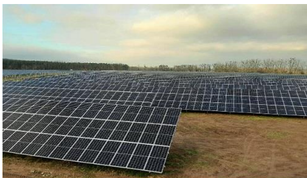
Solarpark "Metzdorf II"; Bild: swt
