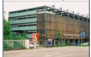
Abb. 2.4.10. Quartiersparken Solargarage Vauban
