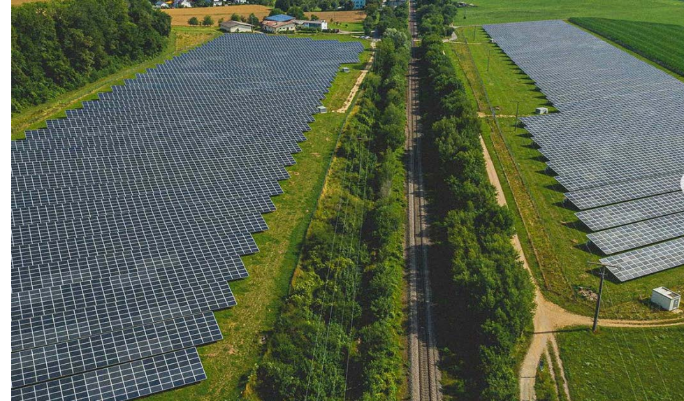
Solarpark Zwiefalten der enBW, Inbetriebnahme 2017 Leistung und Fläche: 5,2 MWp auf 7 ha (5.800 MWh/a)
