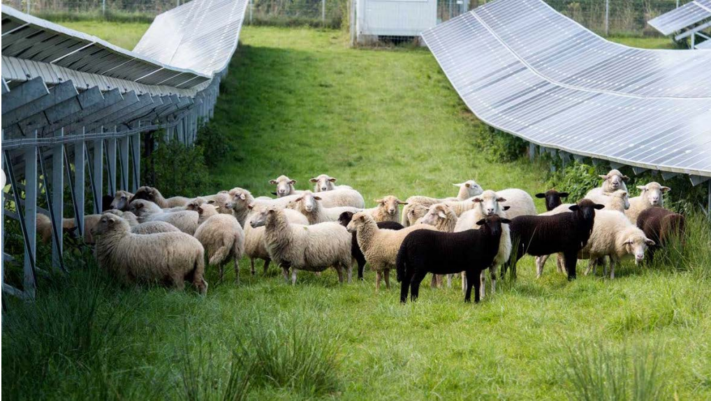
Solarpark Leutkirch der enBW, Inbetriebnahme 2014 Leistung und Fläche: 2,9 MWp auf 6,9 ha (3.200 MWh/a)
