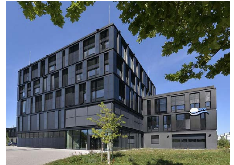
Blick von Süden (Fotos: ZSW)
